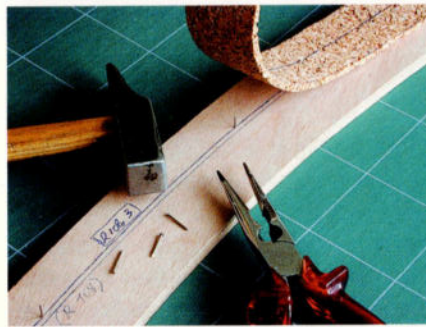
Figure 93: Pour que les tracés marqués respectivement sur la plate-forme et sur la semelle de liège coïncident lors de leur assemblage, j'ai l'habitude de piquer le premier à l'aide de fines pointes sur lesquelles je peux ensuite enfoncer le second au toucher.
