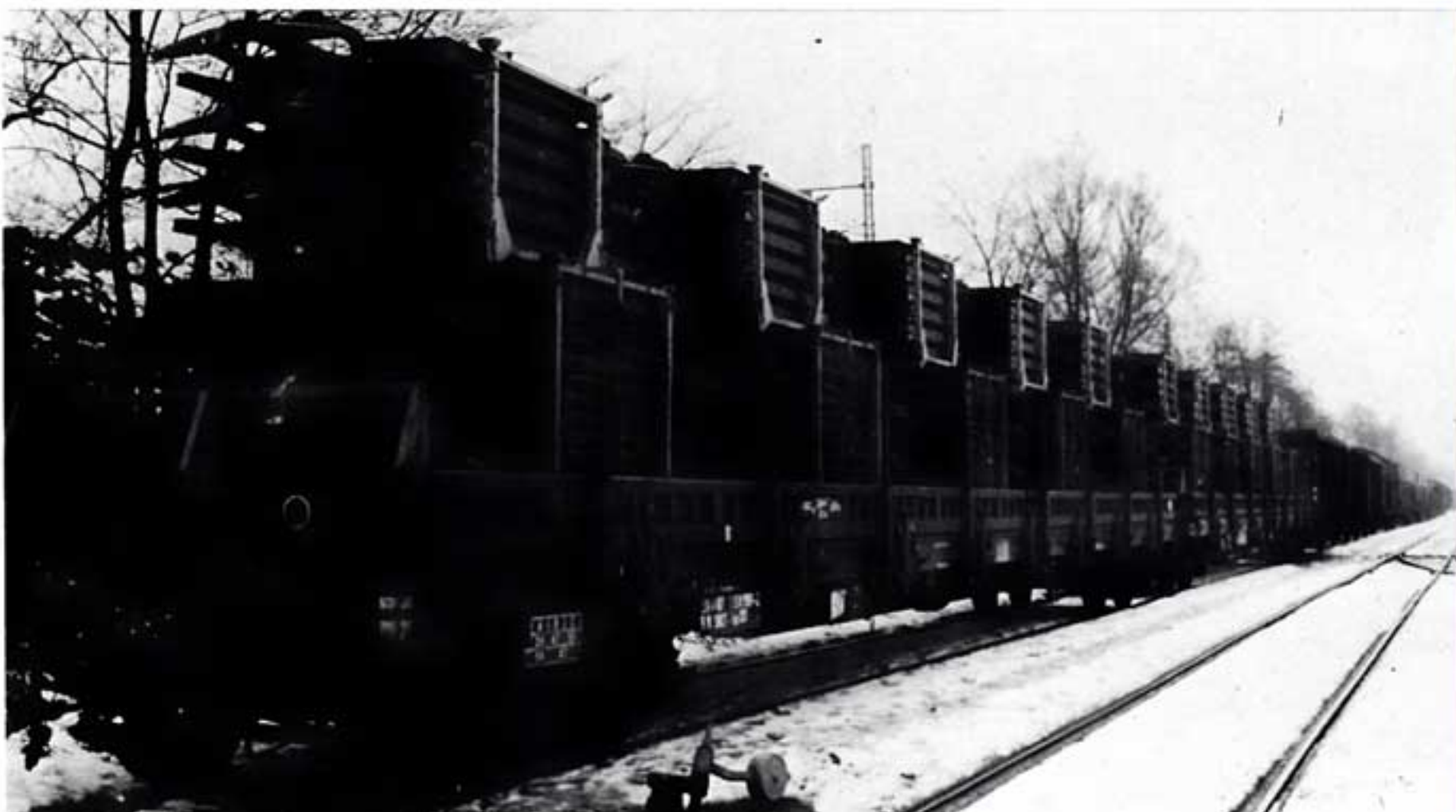
De onderstellen van de wagens komen aan in grote hoeveelheden.
