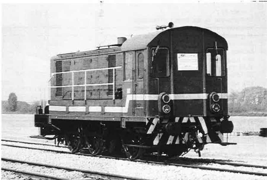
Onder deze nummerloze blauwe livrei steekt de ex-8503, die de firma "Locorem" heeft aangeschaft voor een prikje. Voor deze 45-jarige begint misschien wel zijn tweede leven! In ieder geval maakt hij zich op de foto dienstig bij de aanleg van de HSL-werfbasis te Antwerpen Noord. 24-4-2002. Foto : Erik Heylen.
