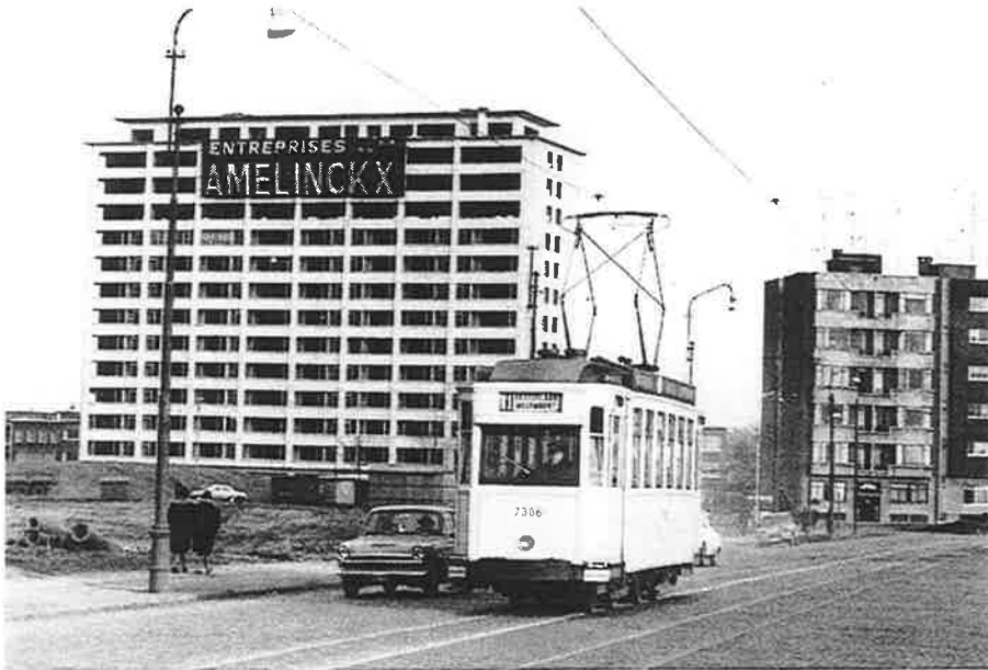
Foto 7 (J. Cohn) : De 7386, die intussen een panto heeft gekregen, op lijn 11 langs het vestingterrein aan de Borsbeekse Poort, juist vóór het begin van de bouwwerken voor de aanleg van de Antwerpse Ring. Februari 1967.
