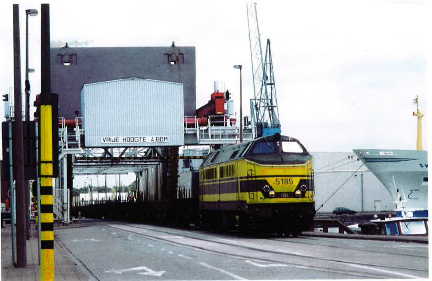
Op 11-7-02 beweegt de .5185 zich langzaam over de Oosterweelbrug in de Antwerpse haven. Niet alleen de brug maar ook het wegdek moet hier over een halve kilometer "gedeeld" worden met het wegverkeer, wat wisselijk wordt opgehouden tijdens de doorrit. Aan de blijkbaar nog goede conditie van deze zware zesasser is niet te zien dat zijn laatste rit heel nabij is... Foto : Erik Heylen.
