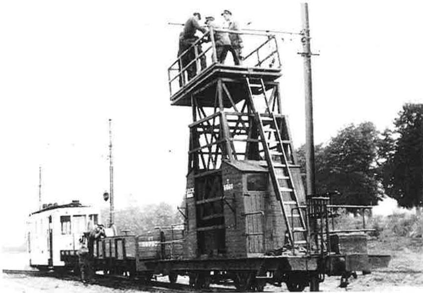
Foto 4 : Dezelfde T.51560 in 1957, achter ART.42 en goederenwagen VT.59750 (VT betekent Voies et Travaux : Wegen en Werken), te Strombeek-Bever tijdens de aanleg van de parking-ringlijn voor de Expo 58. Deze ringlijn werd na afloop van de Expo weer afgebroken.
