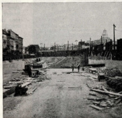
Ceci fut jadis la place Jamar, à Bruxelles, près de la gare du Midi. On y creuse la sortie du tunnel venant de la gare souterraine des tramways.
