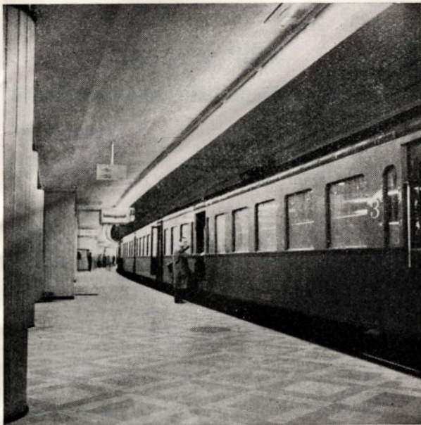
Gare Centrale. Train à quai. (Photo Gérard S. N. C. B.).
