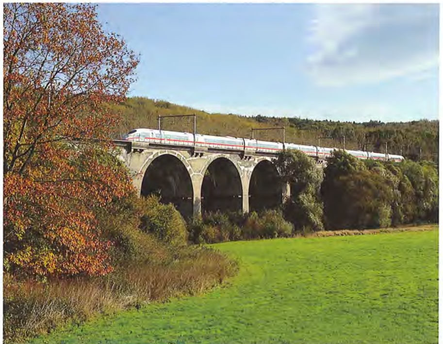
Tijdens de derde testrit reed de ICE 3 verder tot Liège. De ICE 3 op het viaduct van Remersdaal in het prachtige herfstlandschap, tijdens zijn derde testrit naar Liège. Foto Max Delie
