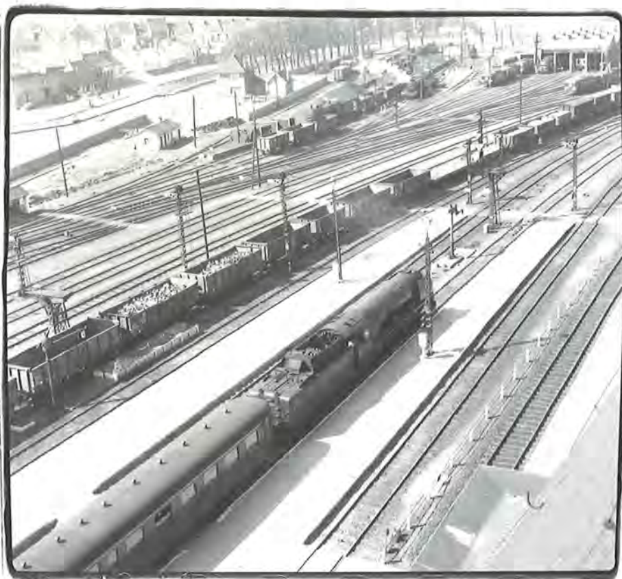
1. Op deze foto, genomen van op het stationsgebouw, zien we de stelplaats op de achtergrond, met daarachter het kanaal. Er zijn eveneens heel wat interessante details, die typisch zijn voor het tijdperk III. Een type 1, aan kop van een directe trein, wacht op spoor 3 op het vertreksein, terwijl spoor 6 ingenomen wordt door een lange rij goederenwagens. Let op de twee waterkolommen van verschillende types en de sintelbak naast één van deze waterkolommen, tussen de sporen 5 en 6. Alle seinen zijn mechanisch en de hoofdseinen behoren tot het driestandenseinstelsel. Tussen de sporen 1 en 2, en naast de asput, is een reling geplaatst. Er staat trouwens een locomotief boven de asput, terwijl een andere stomer enkele lege bakwagens komt ophalen bij het kolenpark. Foto: A. Dutilleul, 1961.
