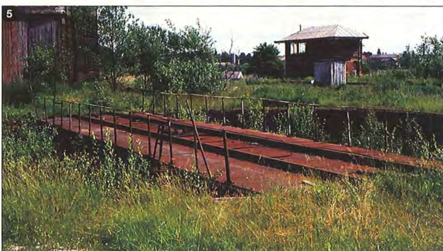
4 & 5. Voorbeeld van één van de zeldzame ringloodsen in België, Florennes-Central, waarvan de 6 sporen toegankelijk waren via een kleine draaibrug. Het onkruid neemt langzaam maar zeker de bovenhand op de sinds enkele jaren aan hun lot overgelaten installaties. Foto's: André Saenen.
