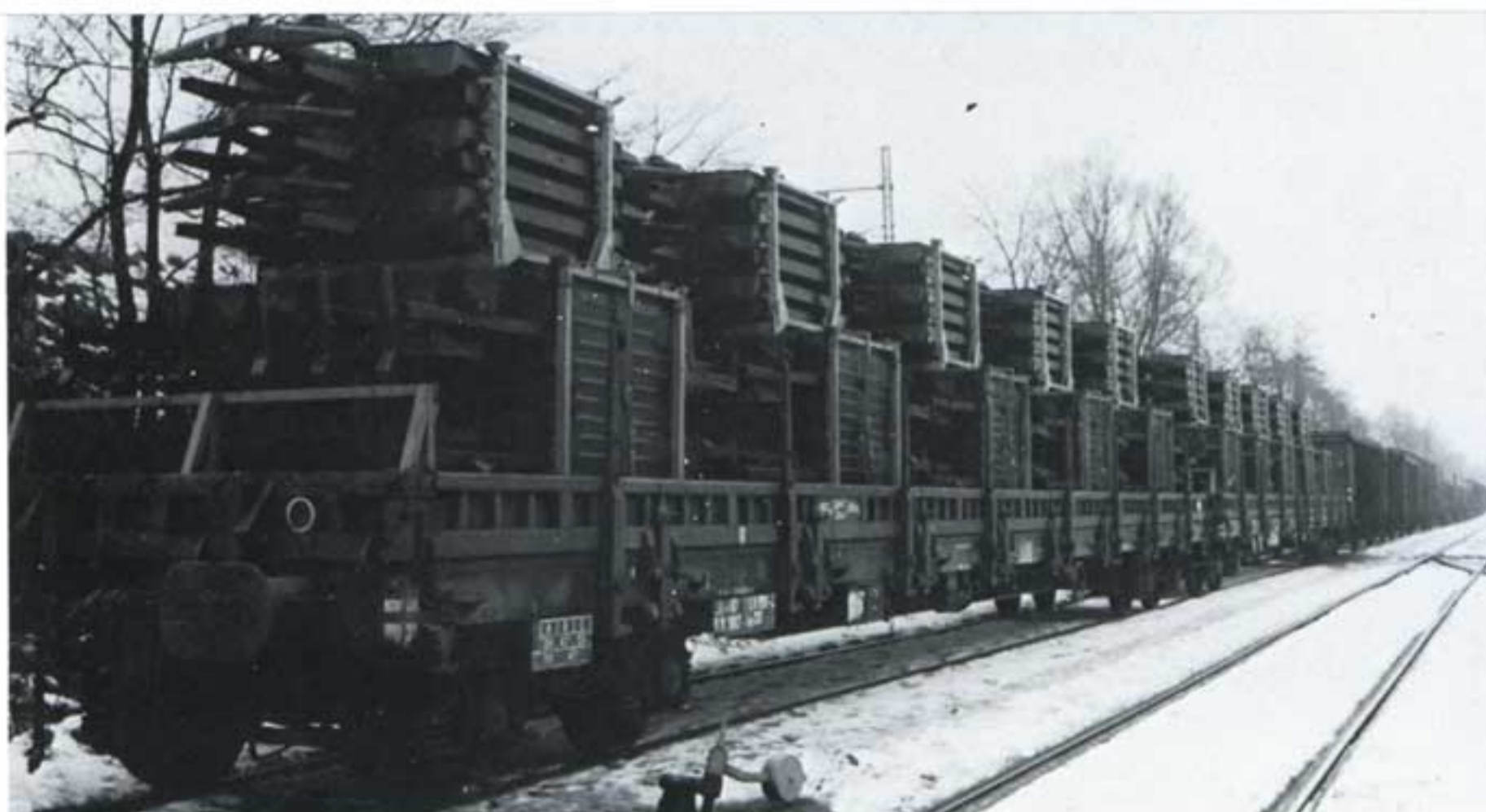
Les châssis de voitures arrivent par wagons entiers.
