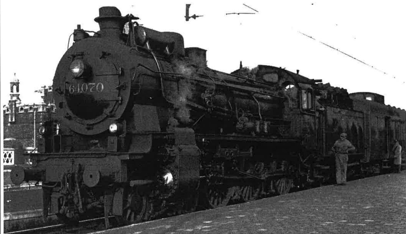
La 64.070 de la remise de Merelbeke remorque un convoi de voitures L. Elle est photographiée sous les caténaires de la ligne Bruxelles-Oostende par Paul Pastiels en gare de Gent-Sint-Pieters le 20 août 1965. Cette ex-P8 prussienne a été «belgicisée» par adjonction d'un réchauffeur d'eau ACFI entre la cheminée et le dôme de prise de vapeur. (Photo n°560 parue dans «Vapeur, volume III» de Max Delie).
