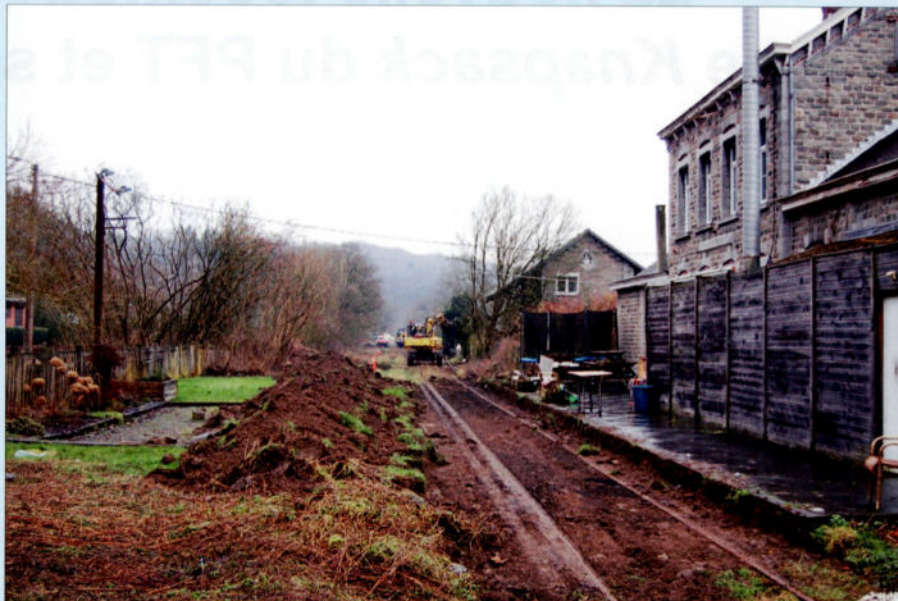
Travaux de terrassement à hauteur de la gare d'Evrehailles-Bauche le 14 février 2016. CFB-PFT.
