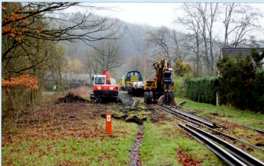
Sur le site de la gare d'Evrehailles-Bauche, les nouveaux rails sont déchargés du wagon et sont placés en attente à côté de l'ancienne voie. CFB-PFT, 14 février 2016.
