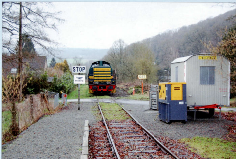
Le train de travaux remorqué par la 7341 stationne au-delà du passage à niveau de la gare provisoire de Bauche le 14 février 2016. CFB-PFT.
