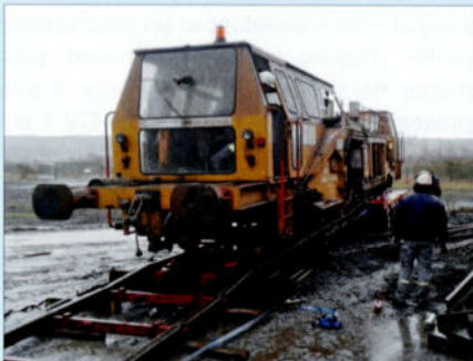
Le 14 janvier 2016, la bourreuse acquise par le PFT est chargée sur une remorque routière sur le site ArcelorMittal de Chertal. Philippe STERCK.
