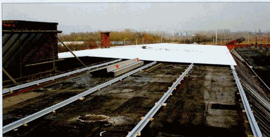
Dans le courant du mois de mars, la toiture du bâtiment principal du Musée du Rail a été refaite. Après enlèvement de la verrière, un bardage métallique a été posé sur des longerons fixés aux poutrelles existantes. PFT, 21 mars 2005.
