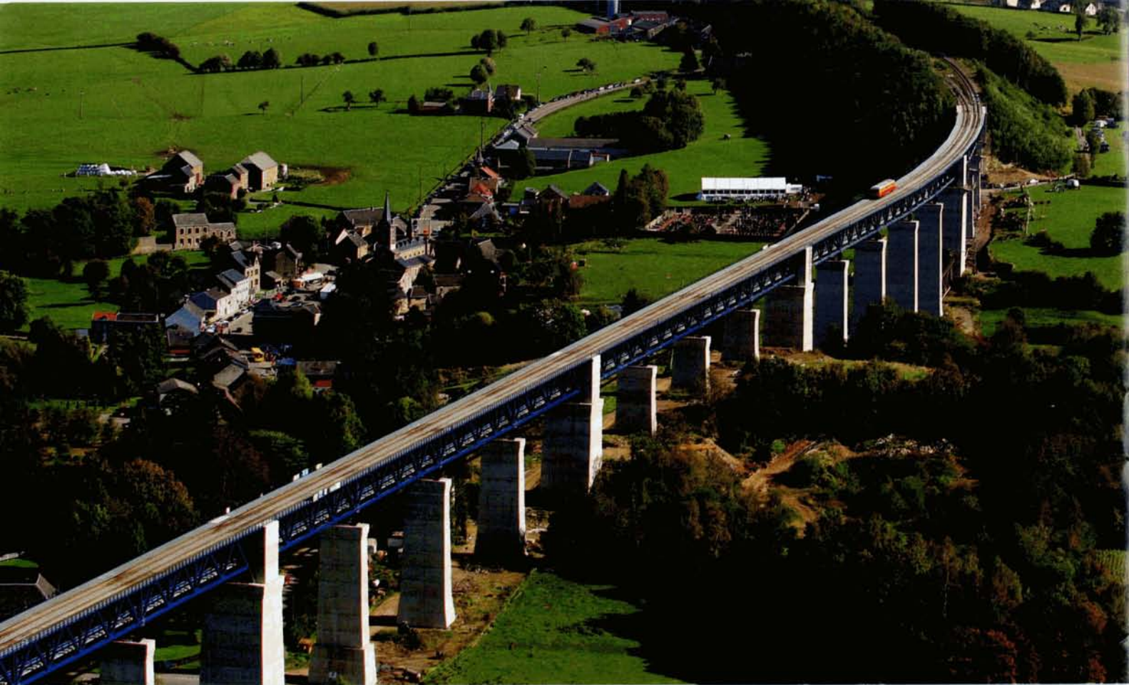
Une vue aérienne du 4506 sur le viaduc de Moresnet, lors des navettes entre Montzen et les "Trois Bornes". Michel HANSSENS, 3 octobre 2004.
