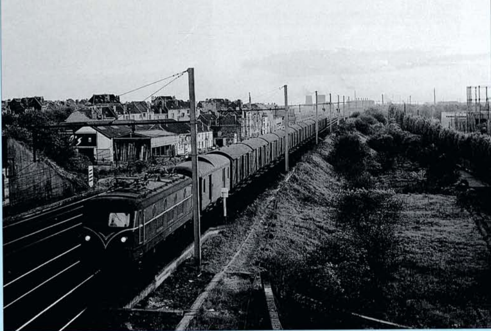
PHOTO-THEME 58 La tranche des wagons porte-autos de l'Auto-Couchette-Express 82, au crochet de la 123.033. La rame est composée d'un fourgon suivi de 13 wagons du type Hbckss. Bruno DEDONCKER, collection PFT.
