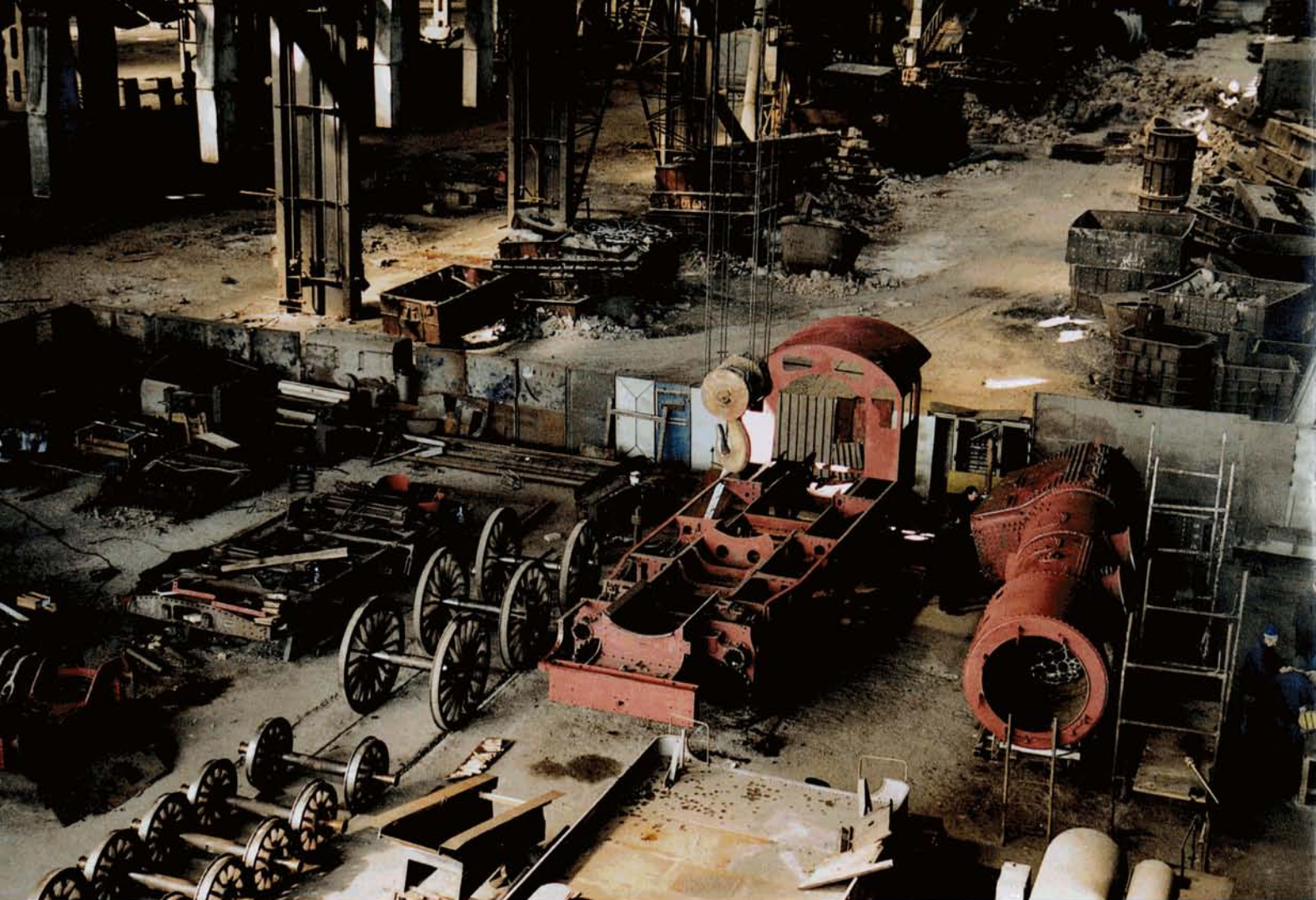
Vue générale de la P8 230.084 dans l'atelier de Cluj Napoca. A gauche, les essieux démontés qui viennent d'être vérifiés; au centre, le châssis qui a reçu sa cabine de conduite; à droite, la chaudière révisée. La remise en état de la P8 - grâce à vous - est bien devenue une réalité... Cluj Napoca, 10 avril 2003.
