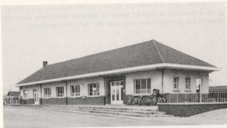
Un bâtiment frais et pimpant pour accueillir les voyageurs à Blaton.
