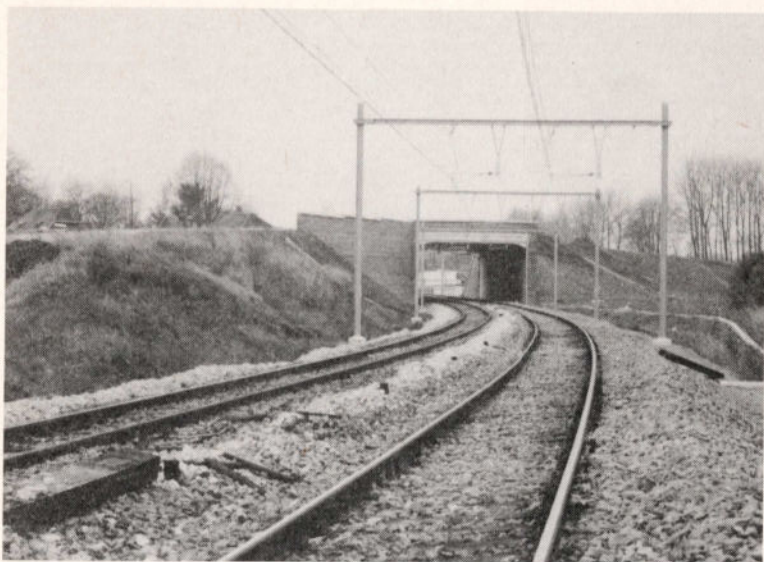
Des passages à niveau ont été supprimés et remplacés pour des ouvrages d'art. A Callenelle, notamment ...
