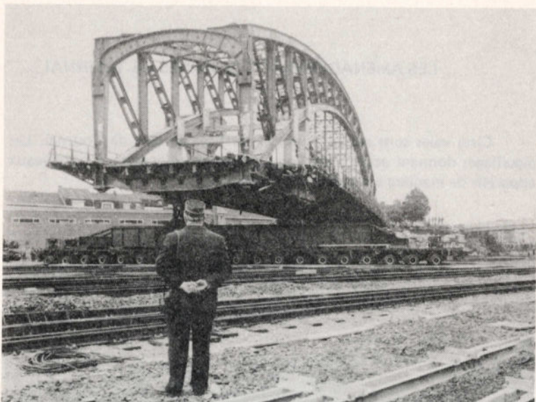
Le déplacement du Pont des Vendéens, à Tournai, précédant sa démolition, fit l'objet d'une opération particulièrement spectaculaire.
