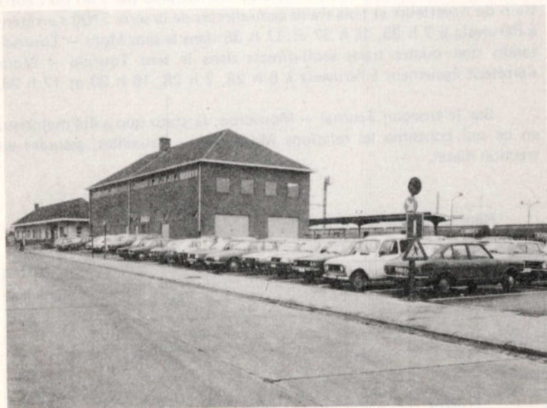
On a profité du réaménagement des gares pour prévoir des parkings pour automobiles. Celui de Blaton, par exemple, montre qu'il était attendu.
