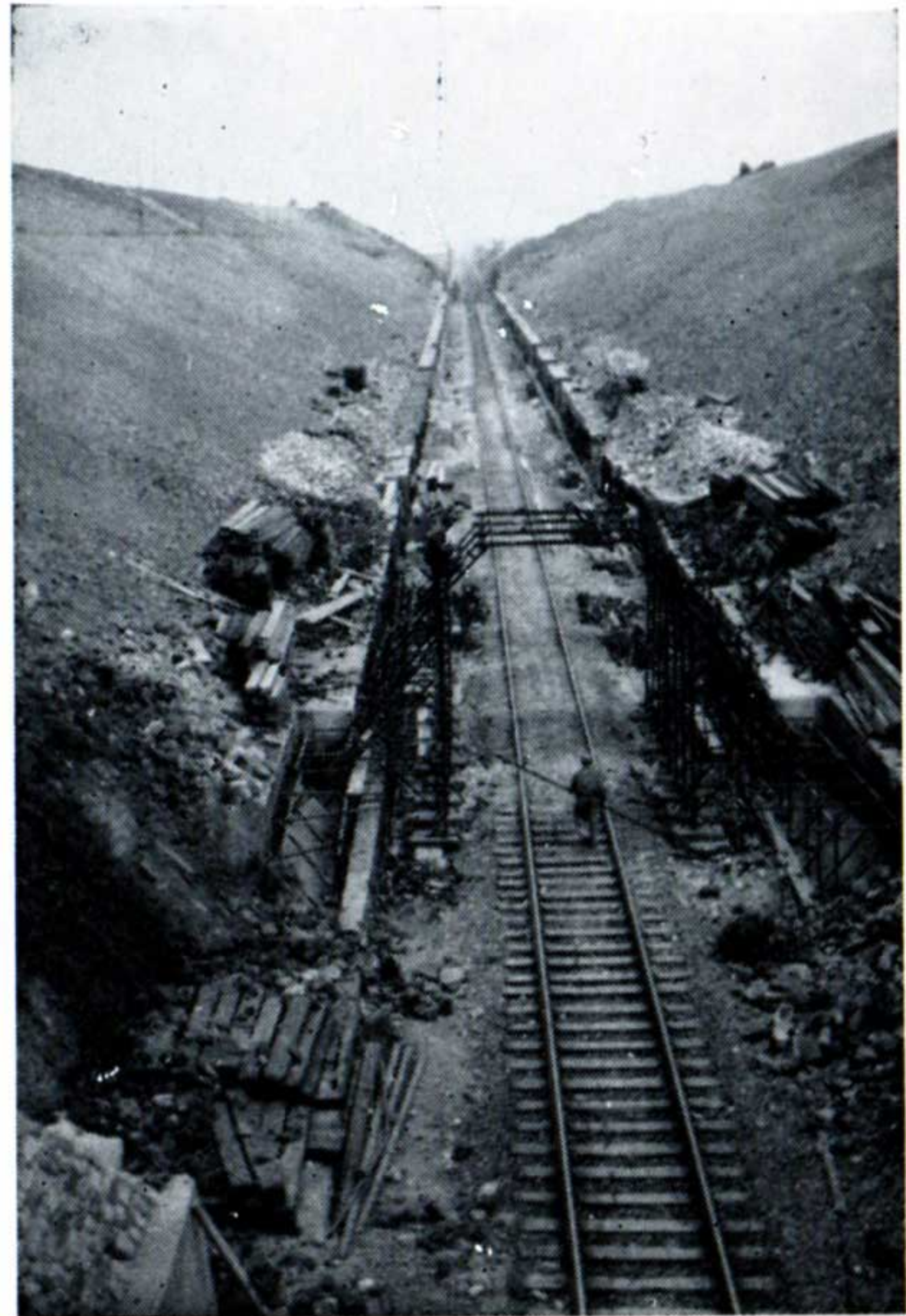
Vue de la nouvelle tranchée vers la fin des travaux. (Photo SOCOL)
