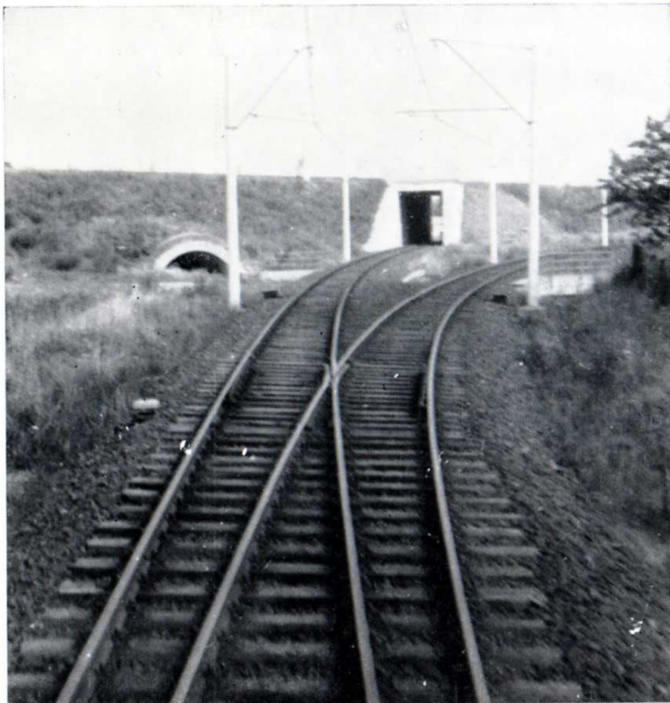
Les ouvrages de Bonn West, point de rencontre du Rheinuferrbahn et du Vorgebirgsbahn.
