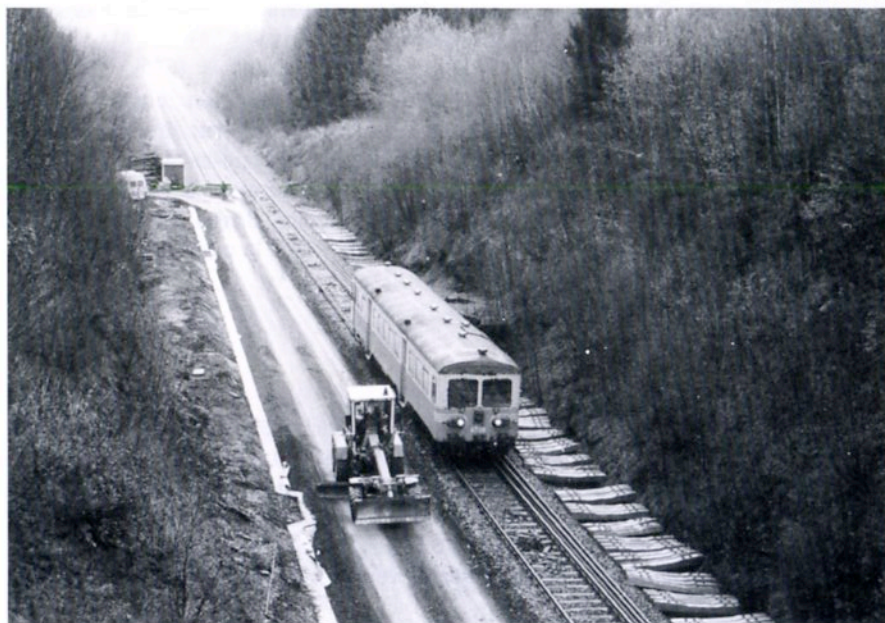
Ligne 165 (Athus-Meuse) : le 16 avril 1998, à Orgéo (BK 76), la voie A est hors service pour des travaux de voie ; l'autorail 4508 assurant le train L 7660 Virton -Bertrix et Libramont circule normalement sur la voie B (photo M. Grieten)
