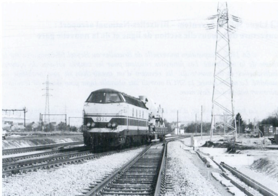
Le 30 mars 1998, à Y Voroux (lignes 36 à gauche / 36A vers Kinkempois à droite), la diesel 6324 pousse un wagon plat chargé d'un camion de béton pour la pose des poteaux caténaires ; la vue est prise en direction de Liège, à hauteur de la sous-station ; la voie au premier plan est le raccordement de l'atelier des wagons de Voroux (photo M. Grieten)
