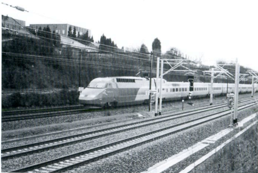
Lembeek : de gauche à droite, ligne 96 où circule un TGV Bruxelles-Paris, à droite en avant-plan ligne 1 avec signaux de commutation 25 kV/3 kV (photo M. Grieten - 10 décembre 1997)
