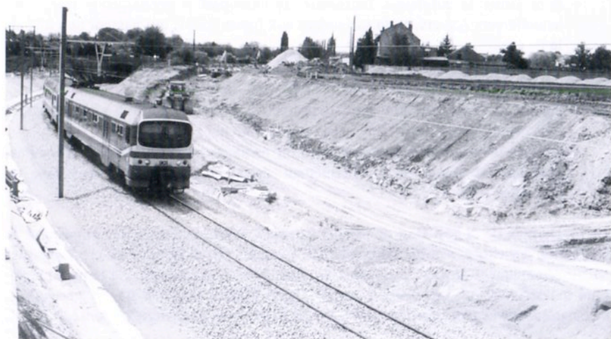
↑ 18 avril 1998 : l'automotrice 905 (IC 6563 pour Bruxelles-Midi) circule sur la voie B de l'ancienne ligne 36C (BK 0.4) ; la voie A de la nouvelle ligne est posée ; la diesel 6299 et le train d'électrification sont à l'entrée du tunnel sous les pistes. ↓ 8 mai 1998 : l'automotrice 901 (IC 6036 vers l'aéroport) circule sur la voie A de la nouvelle ligne (BK 0.3) ; les travaux de terrassement pour la plate-forme de la nouvelle voie B sont visibles. Dans le fond se trouve le pont permettant à la voie A de la ligne 36C de passer sous les 2 voies de la ligne 36 (photos M. Grieten)
