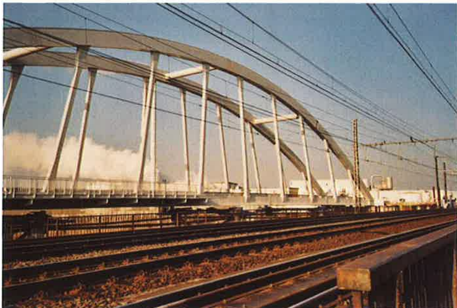
Nog een zicht op de eerste nieuwe brug, gefotografeerd vanaf de oude Netebrug. Duffel 29 januari 2011. Foto Noël Suys.
