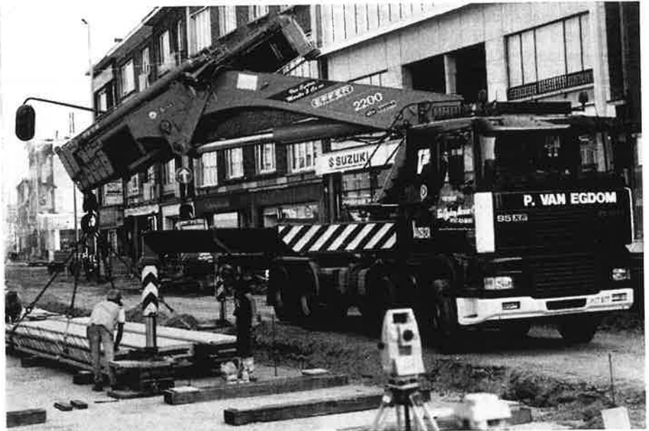
Op 7 september 2004 is men druk doende met het plaatsen van de prefab sporelementen in de Antwerpsestraat te Mortsel. Foto: Luc Couscheir
