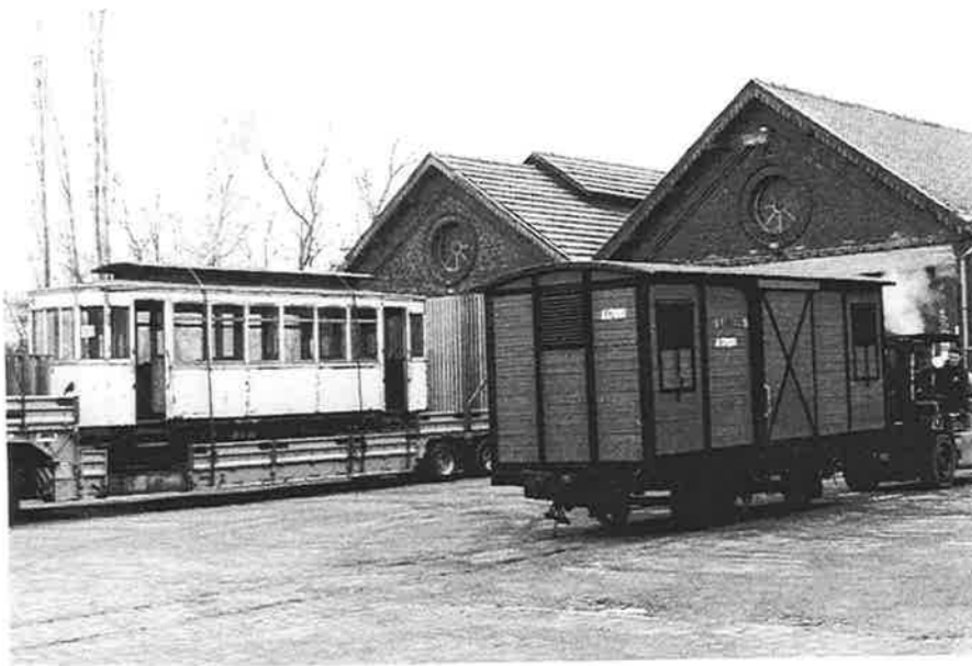
Bijwagen 70 staat klaar voor vertrek terwijl een vorklift de gesloten goederenwagon A17691 over de kasseien terug in de loods sleept. Rails komen er niet aan te pas! Kalken, 28 januari 2000. Foto : Stefan Justens.
