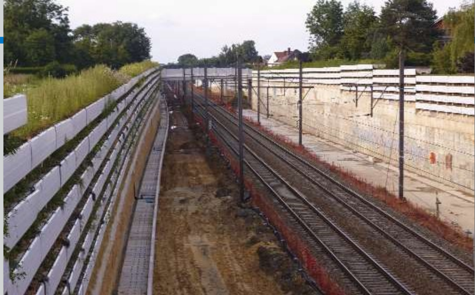
Op deze foto, genomen vanaf de Chaussée Bara te Waterloo in richting Brussel, zien we links en rechts duidelijk de groene muren waarop geluidsabsorberende panelen zijn bevestigd. De brug op de achtergrond is reeds aangepast in dezelfde stijl die alle bruggen op lijnen 124 en 161 uiteindelijk zullen krijgen. Geert PACKET.
