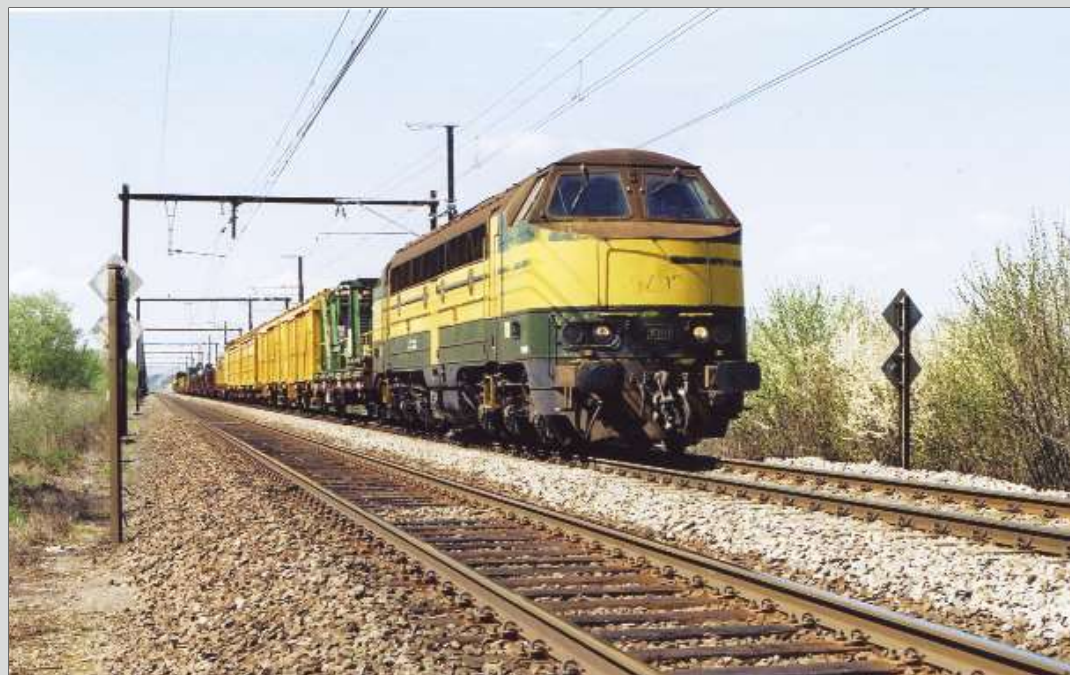
Nog steeds op 20 april 2009 voert de herelektrificatietrein werkzaamheden uit op de grens tussen beide netten, op het spoor naar Luxembourg. Op de foto is duidelijk te zien dat de bovenleiding aan nieuwe masten bevestigd wordt. Op het rechterspoor (richting Luxembourg-Arlon) zijn de oude portieken en kabels nog in dienst. Simon DERIDDER.
