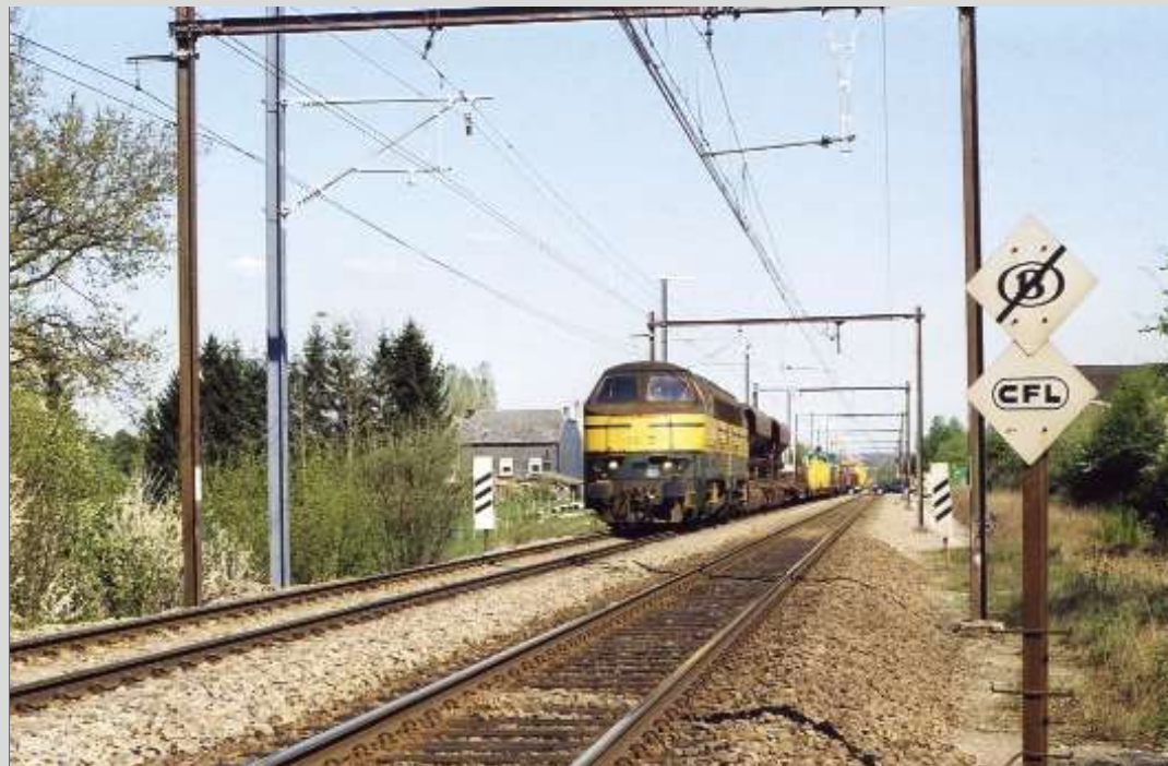
Nog steeds op 20 april 2009 voert de herelektrificatietrein werkzaamheden uit op de grens tussen beide netten, op het spoor naar Luxembourg. Op de foto is duidelijk te zien dat de bovenleiding aan nieuwe masten bevestigd wordt. Op het rechterspoor (richting Luxembourg-Arlon) zijn de oude portieken en kabels nog in dienst. Simon DERIDDER.
