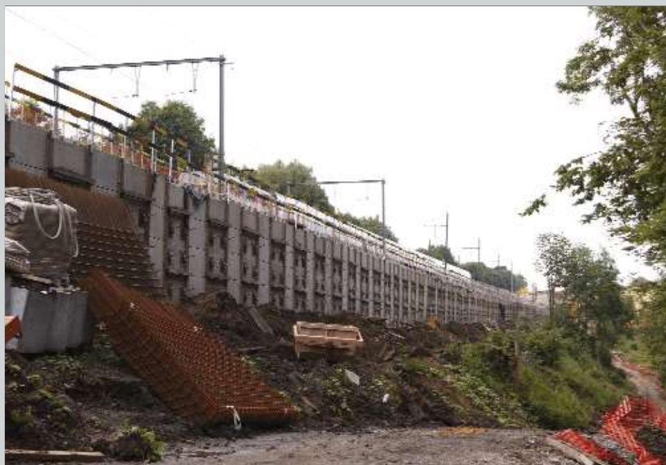
↑ Hier hebben we een zicht richting Brussel, vanop de rue Jean Volders te Braine-l'Alleud. We zien de structuur die naast het bestaande talud is gebouwd. Hierop zullen viaductbakken geplaatst worden. De trein wordt volledig aan het oog onttrokken...
