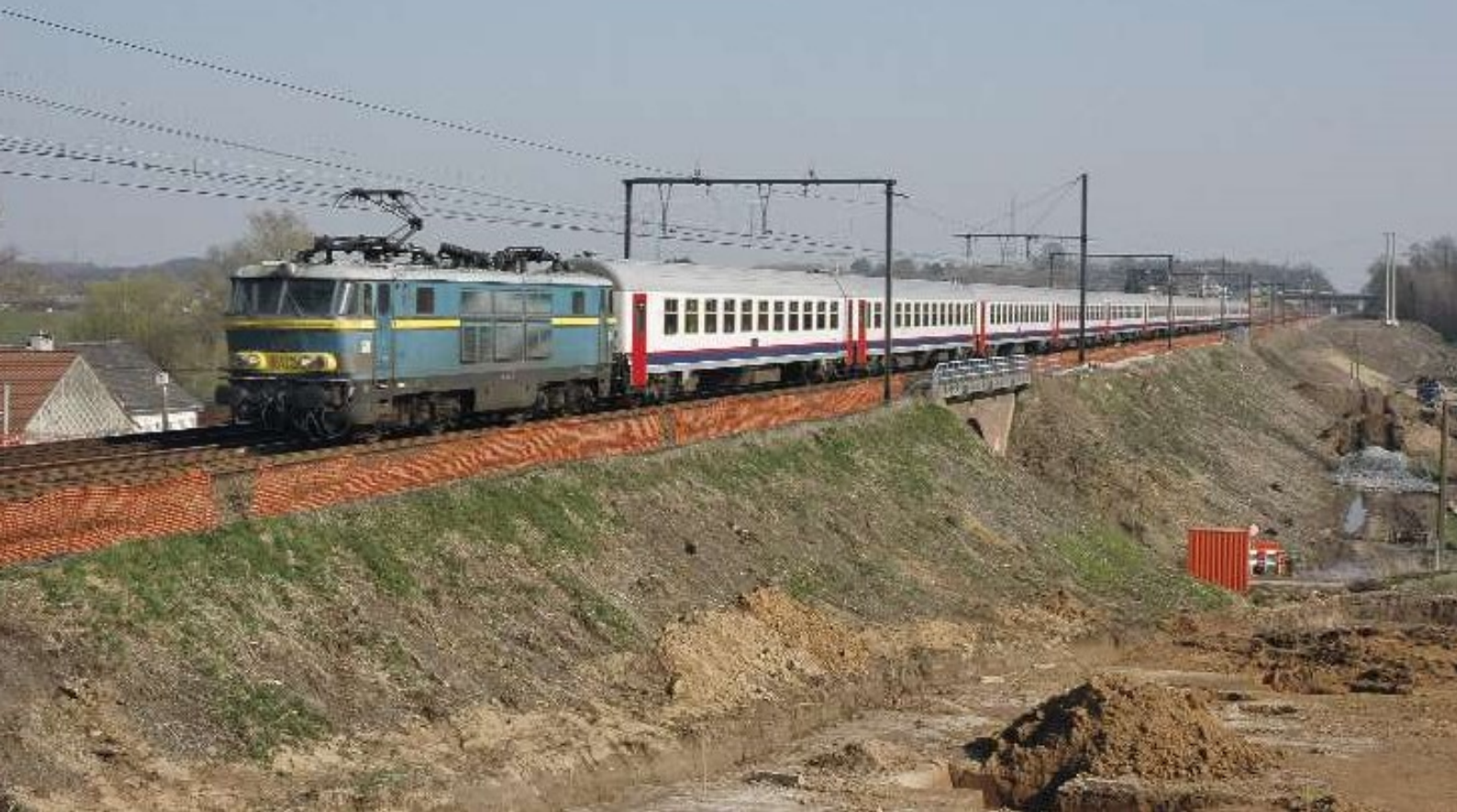
FOTO 92-14 P8002 ter hoogte van Dilbeek, waar de werken om lijn 50A viersporig te maken al begonnen zijn. Pierre HERBIET, 1 april 2009.
