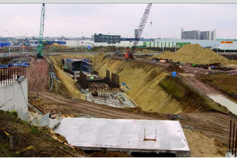
3 Een zicht vanop de Luchthavenlaan naar de luchthaven. Op de voorgrond een deel van de tunnel dat reeds gebouwd is. Tussen de twee kranen zien we de tunnelkoker die onder de op- en afrit door gaat.
