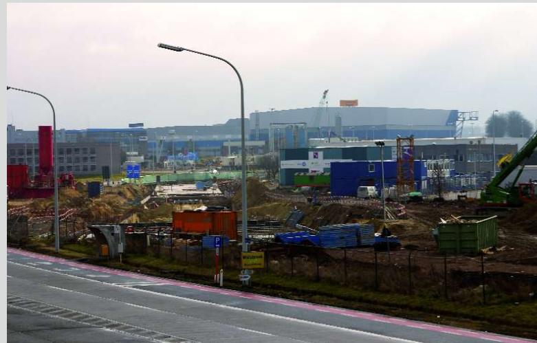
2 Een zicht richting luchthaven, vanop de ondergrondse vertakking.
