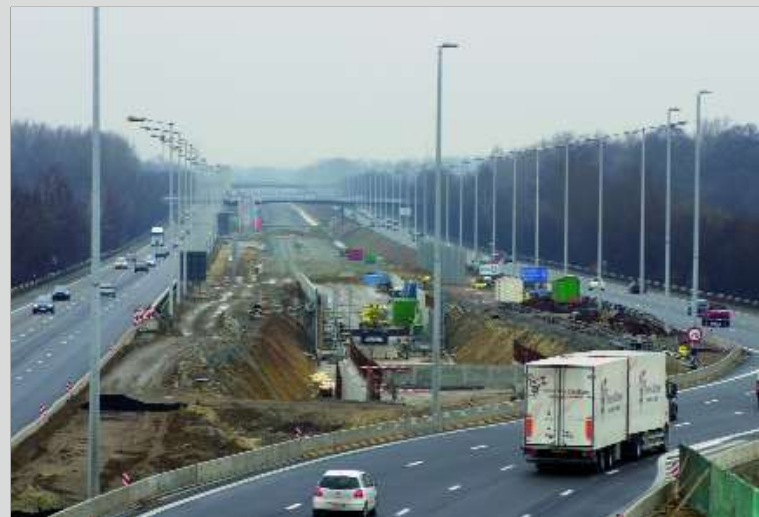
6 Hier zien we zeer duidelijk de omleiding van de autosnelweg. De omleiding is aangelegd boven een reeds voltooid deel van de tunnelkoker dat van de luchthaven komt.
