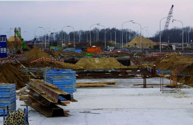
1 Hier staan we boven de tunnel die uit het station Brussel-Nationaal-Luchthaven komt. Vlak voor ons is de ondergrondse vertakking reeds zichtbaar: in de linkse koker komt de tak van en naar Brussel, in de rechtse koker de tak van en naar Mechelen.
