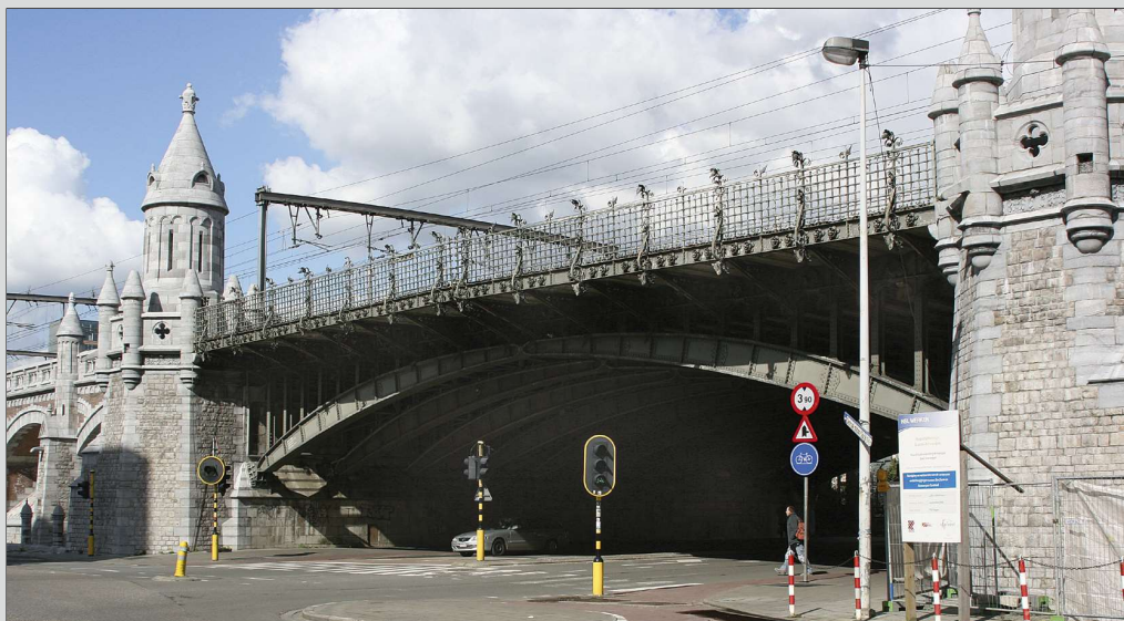
Het bouwwerk telt vijf bruggen. De grootste is deze ter hoogte van de Belgiëlei. Deze werd gebouwd met scharnierbogen, net zoals de monumentale overkapping van het station. Zij is omgeven door grote torens. De andere bruggen zijn stenen gewelven. Walter PINET.
