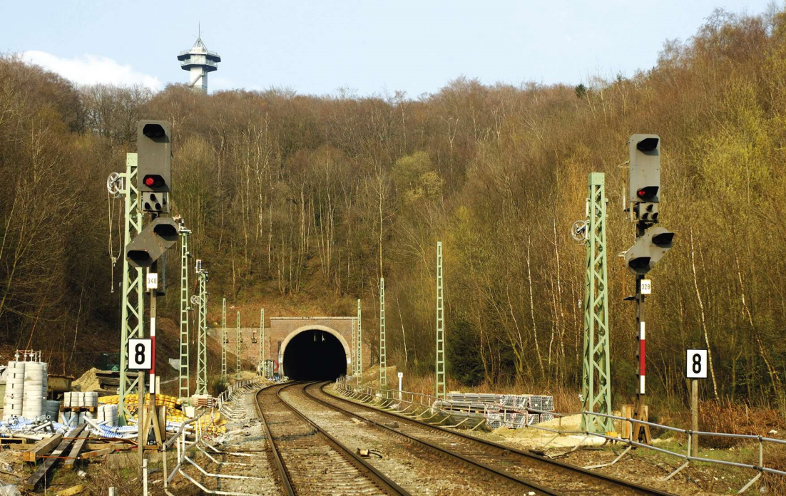
De elektrificatie van de lijn 24 tussen Montzen en de Duitse grens gaat goed vooruit. De eerste proefritten met elektrische tractie zouden reeds in september moeten beginnen om de TRAXX'en te testen. De laatste zes paar palen voor de tunnel van Gemmenich zijn van het Duitse type, de andere Belgisch. 10 april 2008. Dominique ALLARD.
