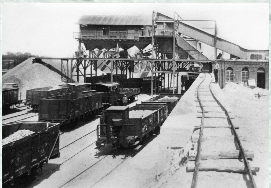
→ Hier hebben we een mooi zicht op de breekmolen (bakstenen gebouw rechts) en de vormings- en laadinstallaties van de S.A. franco-belge des Carrières de Porphyre du Mouplon. Let op het grote aantal wagens van de Belgische Staat, waarvan minstens drie voorzien zijn van een remmershuisje. In het midden rangeert een Cockerill locomotief type IV, met verticale stoomketel, twee wagens. Verzameling Michel DUHAUT.
