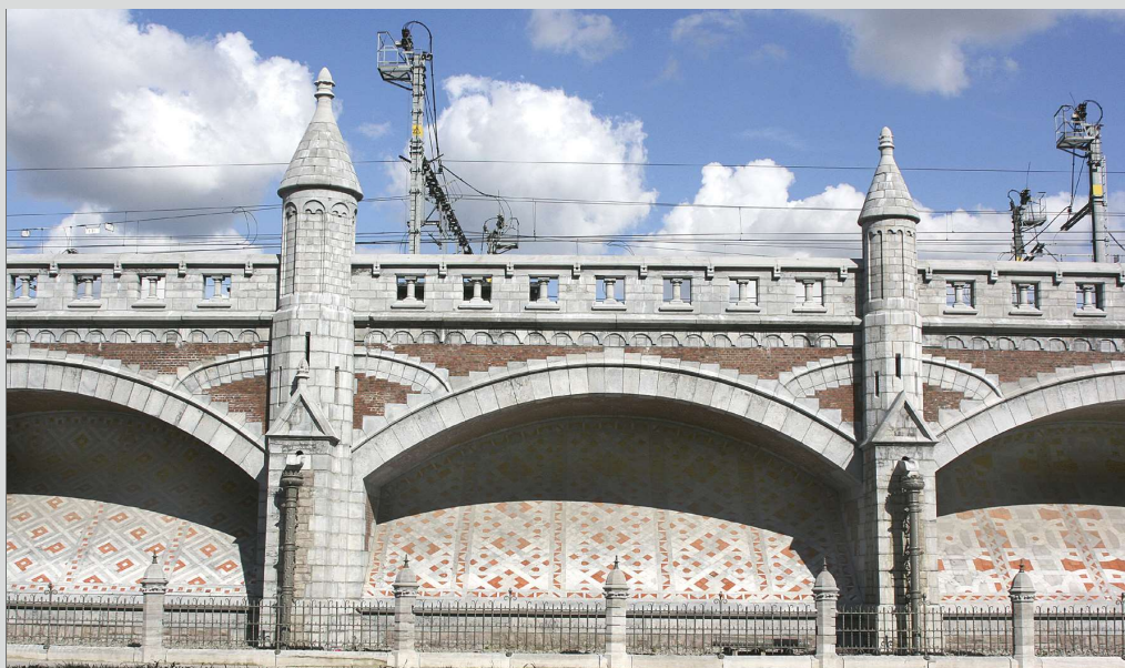
Een zicht op een boog en op de verschillende gerestaureerde mozaïeken op de taludplaten. De mozaïeken zijn van de straat afgescheiden door een smeedijzeren hek tussen paaltjes uit blauwgrijze Vinalmont-natuursteen. Walter
