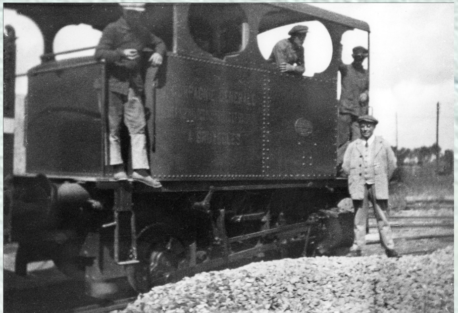
→ Foto's van vroegere industriële locomotieven zijn zeldzaam en meestal van bedenkelijke kwaliteit. Vaak werden ze genomen door het personeel zelf, bedoeld als souvenir. Deze stoomlocomotief met verticale stoomketel was van het type IV van Cockerill. Zij was eigendom van de Carrières des Sarts (Compagnie générale des Asphaltes, Bitumes et Goudrons te Brussel) en werd tweedehands gekocht toen deze Compagnie générale in 1924 de uitbating van de Carrières des Sarts te Lessines voor haar rekening nam die werd stilgelegd tijdens de Eerste Wereldoorlog. Verzameling Michel DUHAUT.
