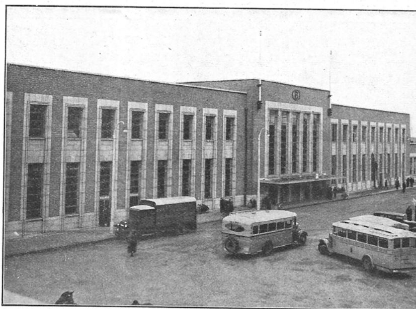
BRUGGE. — De gevel van het nieuw stationsgebouw.
