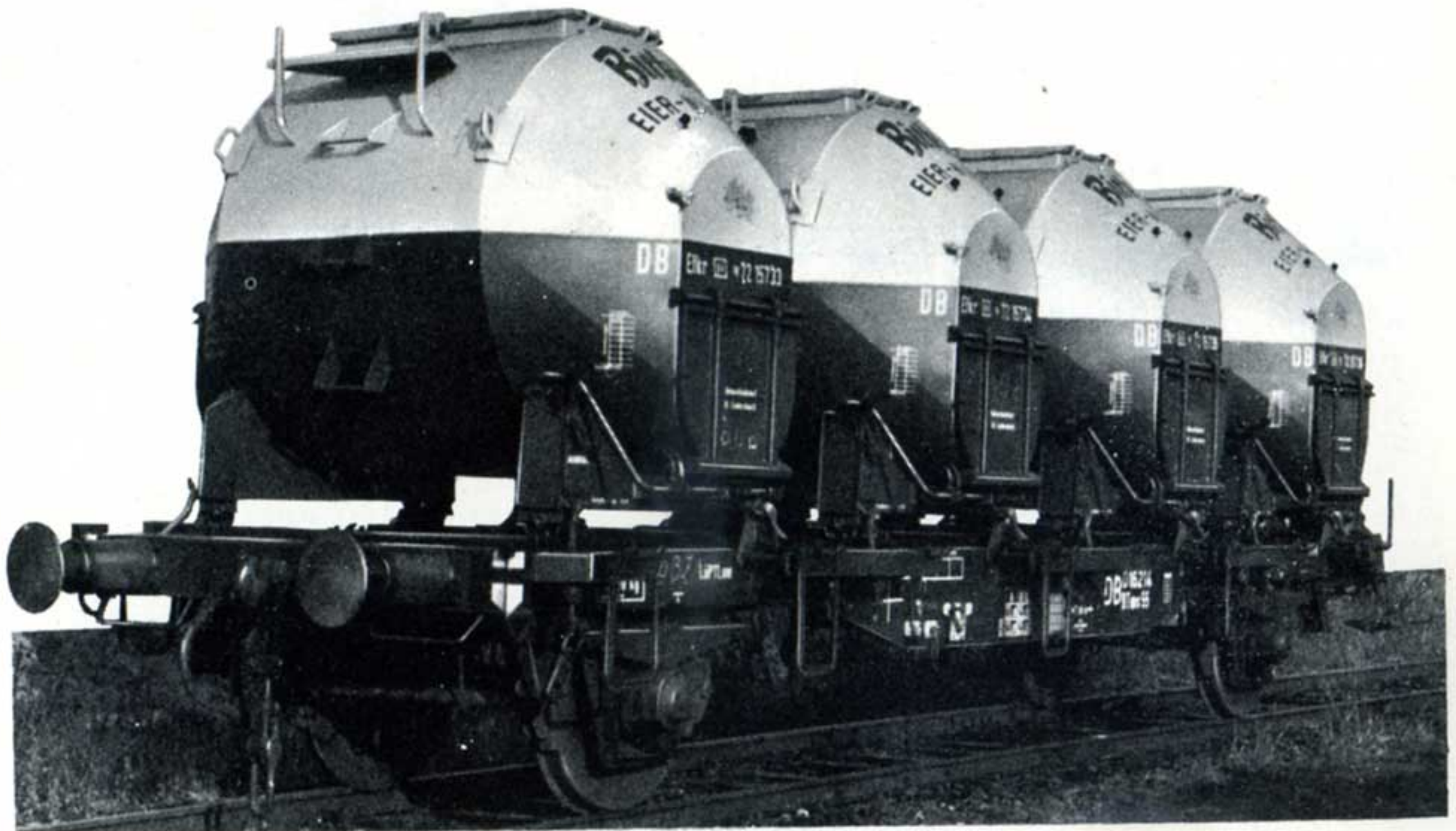
Bild 27: Großbehälter-Tragwagen mit 4 Ef-Privatbehältern = BTms-Wagen
