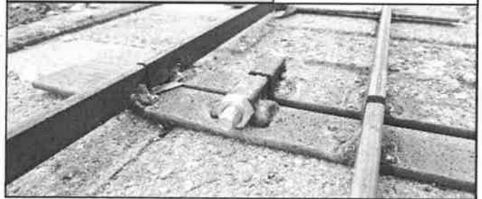
Détail d'un raccord entre coupons de rails droits.
