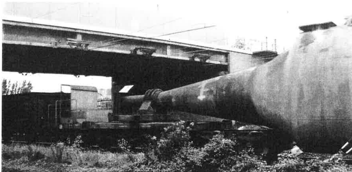
Même convoi, vue du truck support non motorisé, de l'autre côté de la poche à fonte. (photo Cl. Carpet)
