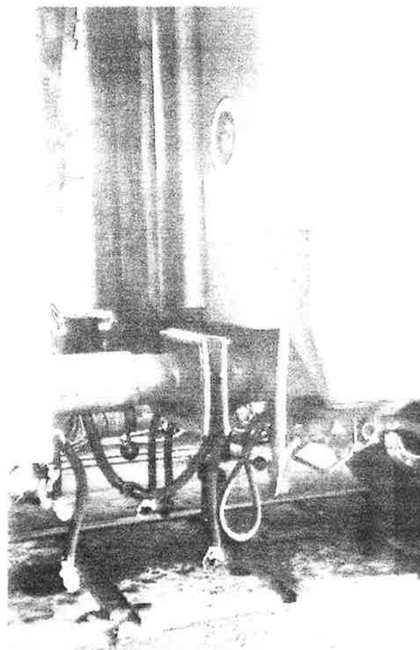
Figure 8 : position du câble électrique
