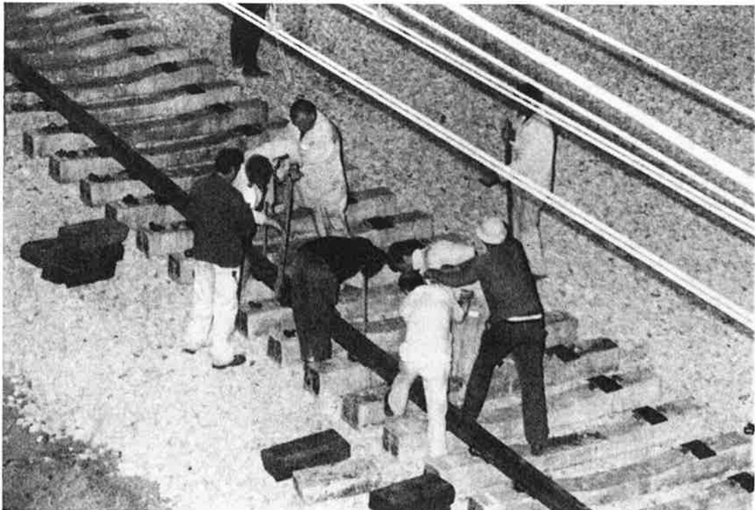
Début de nuit de lundi, une partie de l'équipe du Service de la Voie met en place le premier rail de la 2 ème voie.
