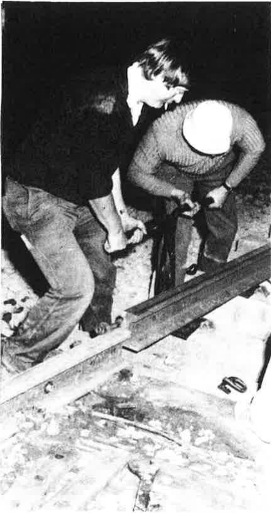
Les volontaires de la SNCB manutentionnent les traverses pour les placer de niveau. Rien ne vaut une bonne finition à la main.
