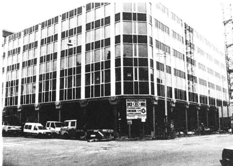
Nouvel immeuble pour la SNCB, rue Bara à Bruxelles. Les travaux ont été confiés à l'entreprise C.F.E.
