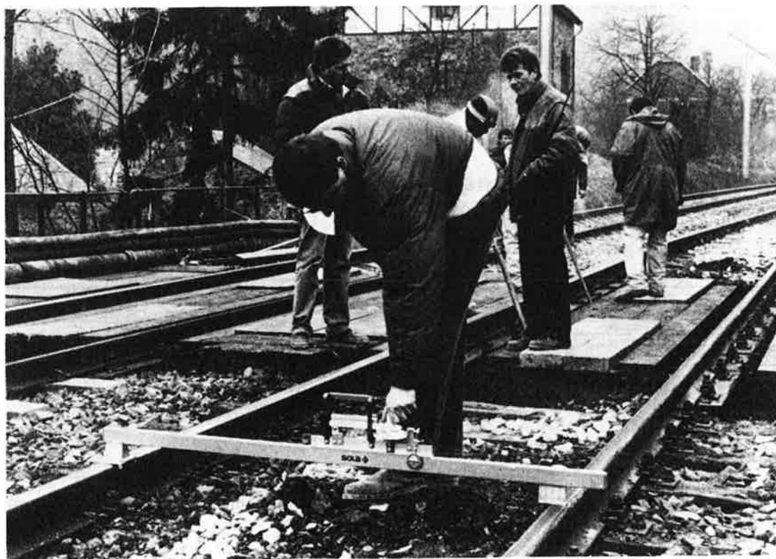
Après le passage des machines, contrôle manuel de l'écartement des voies et du dévers. Ligne 154, Namur-Dinant.
