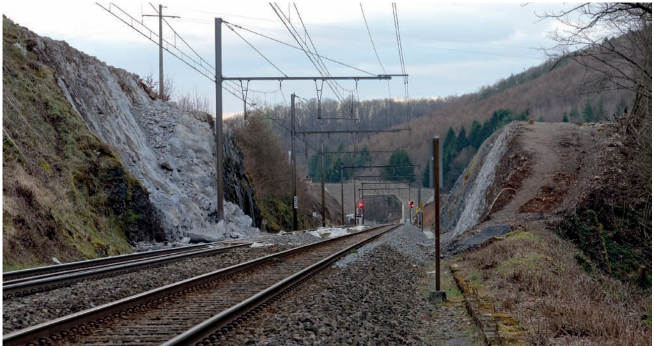
Travaux d'élargissement de la tranchée entre Forrières et Jemelle. La voie B est hors service pour travaux de Grupont à Jemelle.
