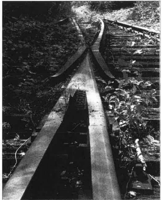
Détails d'un aiguillage à l'entrée de la gare de Warnant sur l'ancienne ligne de la Molinee entre Ermeton-sur-Biert et Anhée-sur-Meuse.
