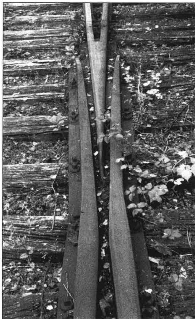
Coeur d'aiguillage fabriqué par Cockerill. Pièce subsistant aux abords de l'ancienne gare de Warnant sur la ligne désaffectée de la Moline. Malgré le manque d'entretien depuis des décennies, les traverses en chêne sont toujours là (photo Claude Carpet).
