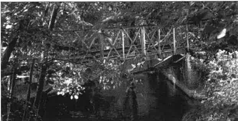
Pont ferroviaire enjambant la Mollignée juste avant la traversée de la route vers les anciennes usines de Moulin. La formation de Warnant, précédant largement cet ouvrage, est située sur la rive gauche avec la ligne 150 qui continue jusqu'Anhée en se raccordant à la ligne Namur - Dinant. Les trains, en provenance de la gare de Warnant, empruntant ce raccordement vers l'usine de Moulin traversaient la rivière à cet endroit en venant de la droite (photo Claude Carpet).
