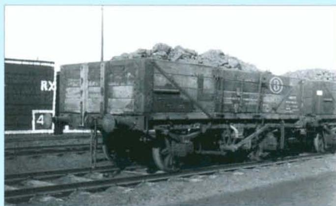
**Le wagon 136.486 de la SNCB. Remarquez le marquage blanc sur le coin du second wagon, indiquant qu'il est pourvu d'une conduite blanche placée par la SNCB. A l'origine, aucun de ces wagons ne possédait un équipement de freinage pneumatique. Le wagon a été construit entre 1918 et 1923. Georges DESBARAX.**
