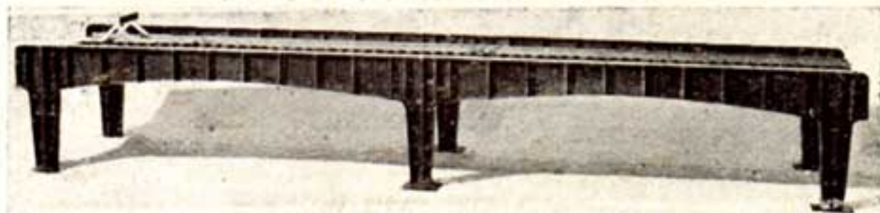
Pont N° 208 — Jonction.
