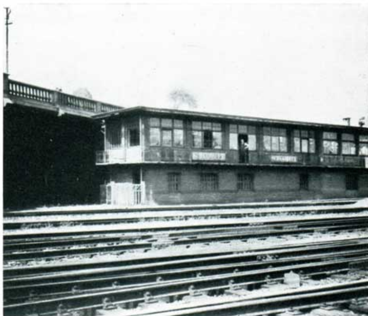
Cabine I de Schaerbeek. Vue extérieure.
