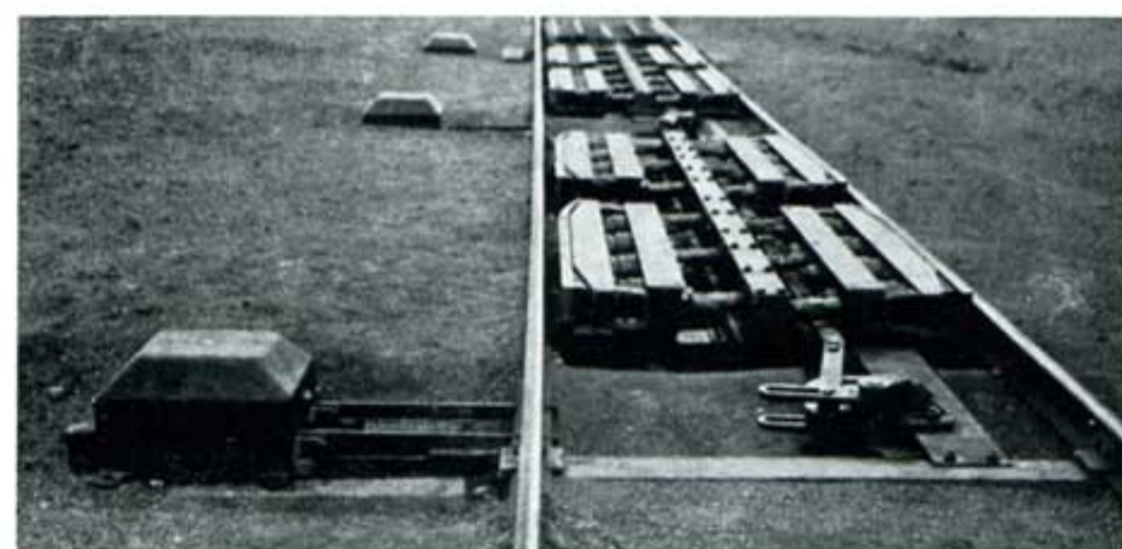
Freinage des wagons pour gare de triage. Mise en place des freins par moteurs électriques.
