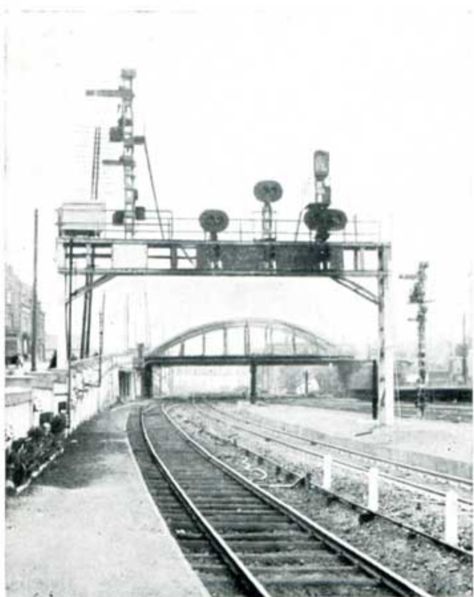
Passerelle avec sémaphore, signaux lumineux principaux et de manœuvre, numéros de voie lumineux, armoire à relais.
