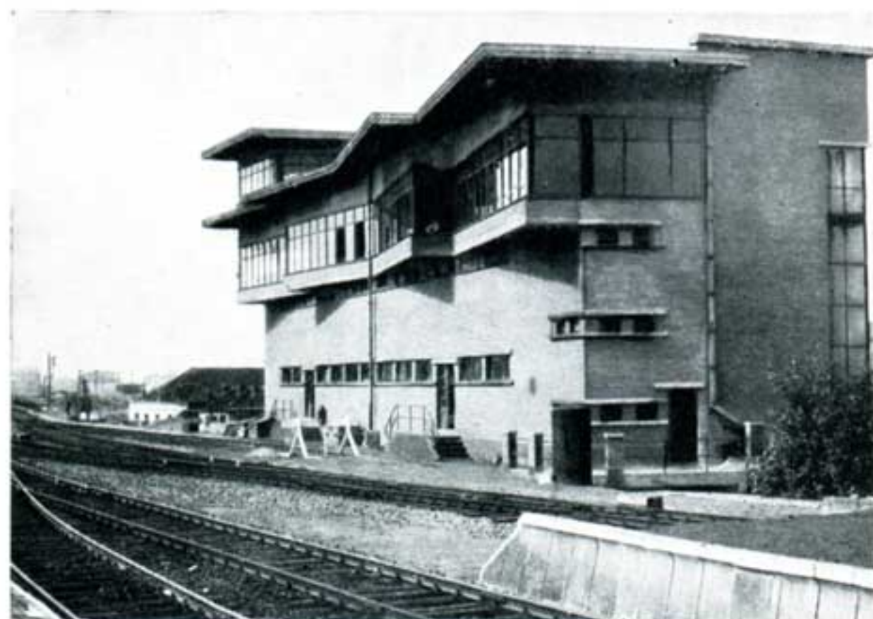
Vue extérieure de la cabine à leviers d'itinéraires de Bruxelles-Midi.
