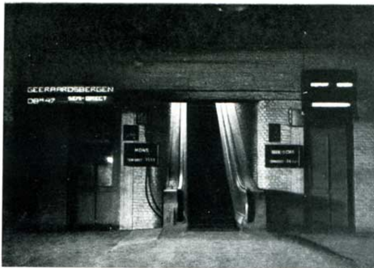
Appareil d'annonce des trains dans le souterrain de la gare de Bruxelles-Midi.
