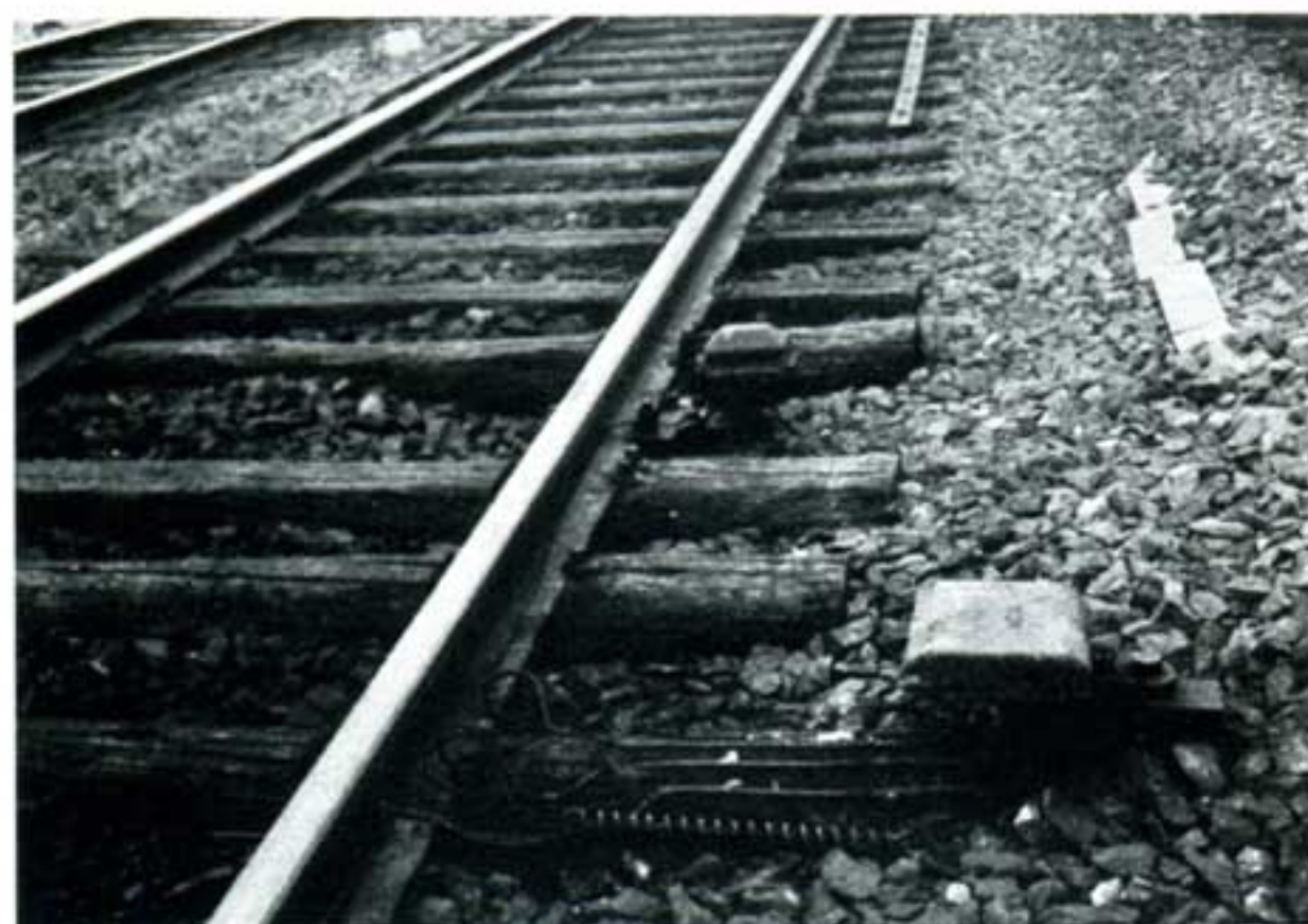
Contact de rail à air avec faible quantité de mercure. A l'avant-plan, la boîte de distribution.
