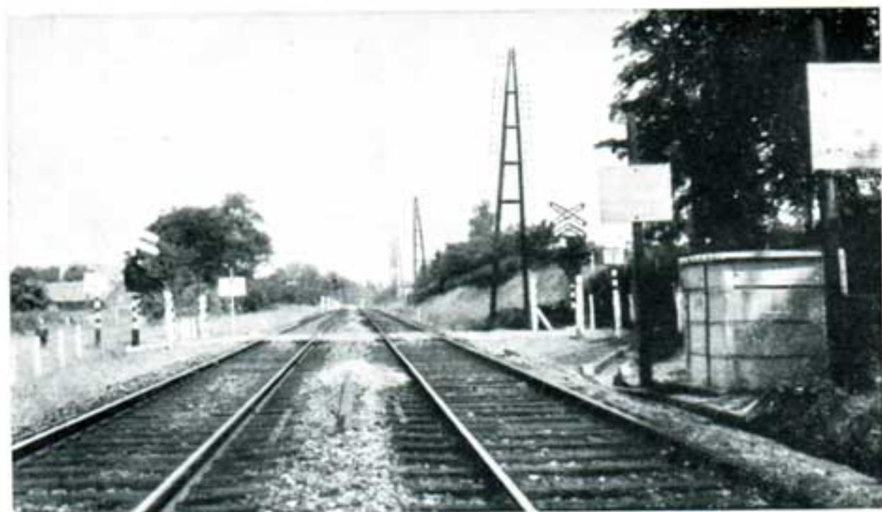
Signalisation de passage à niveau non gardé, à Héverlé. A l'avant-plan, vue de la loge où sont placés les appareils accessoires pour la protection du passage à niveau.
