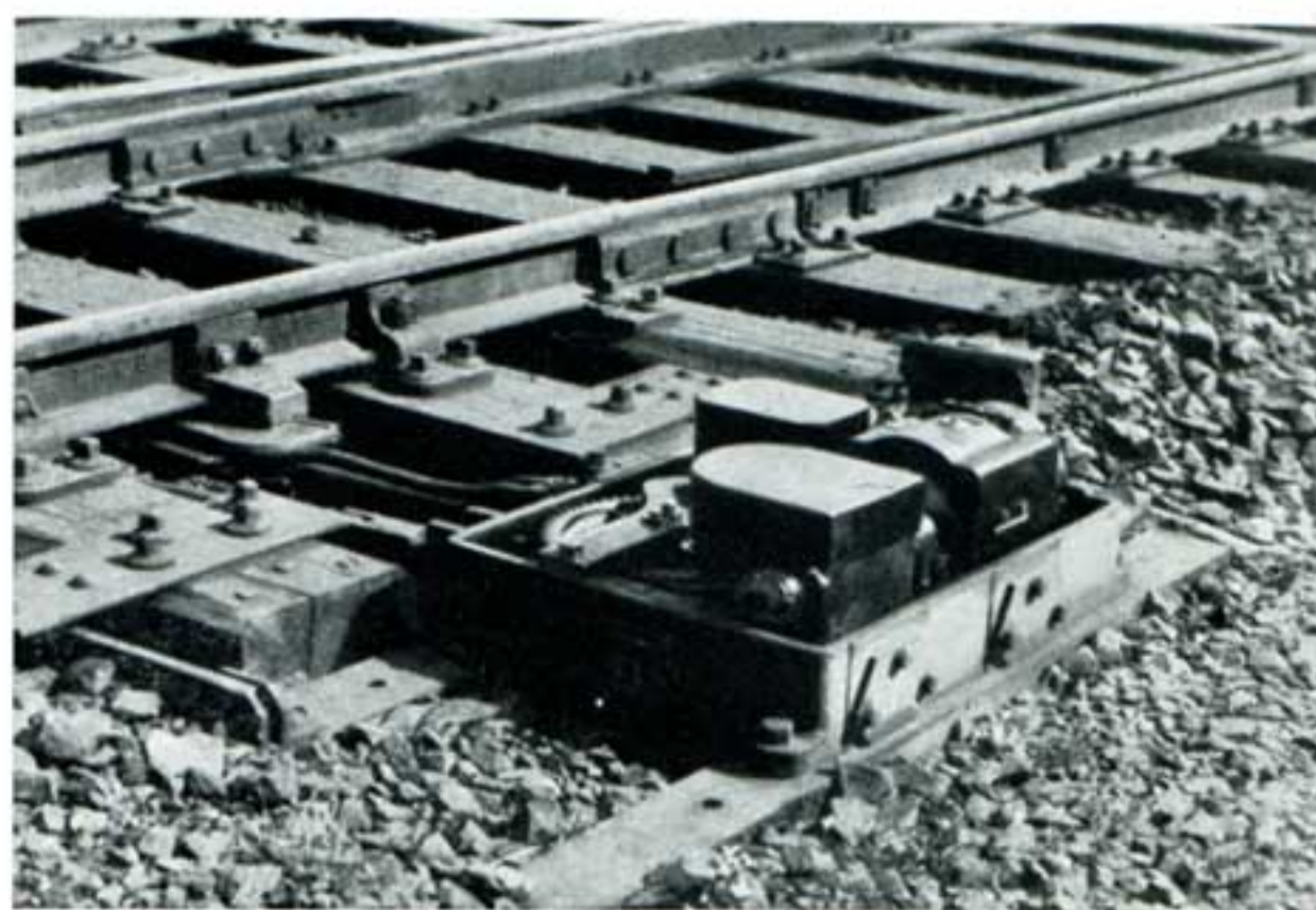
Appareil de manœuvre électrique d'un aiguillage élastique à une crémaillère. Couvercle enlevé.
