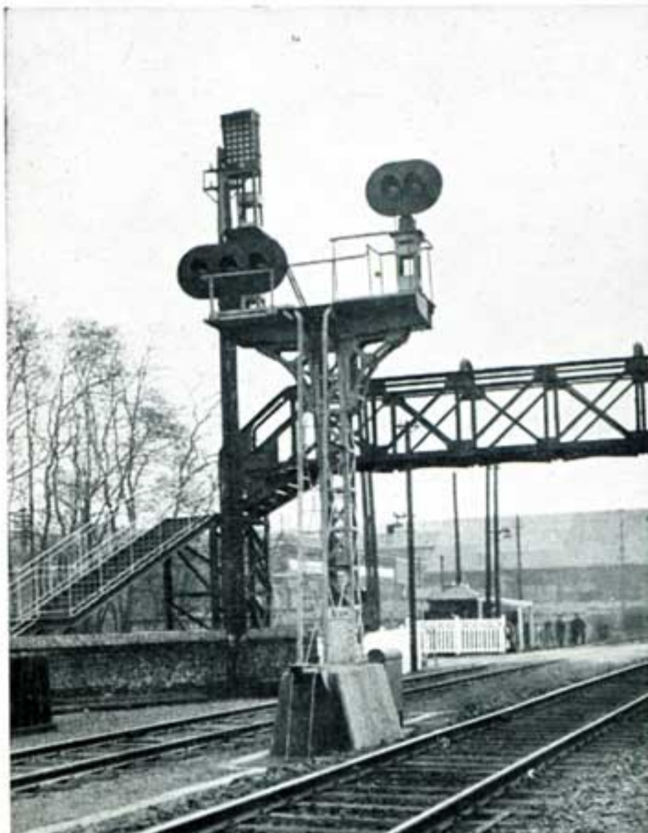
Signaux et indicateurs à numéros lumineux, montés sur un chandelier (Passage à niveau de Marcinelle).
