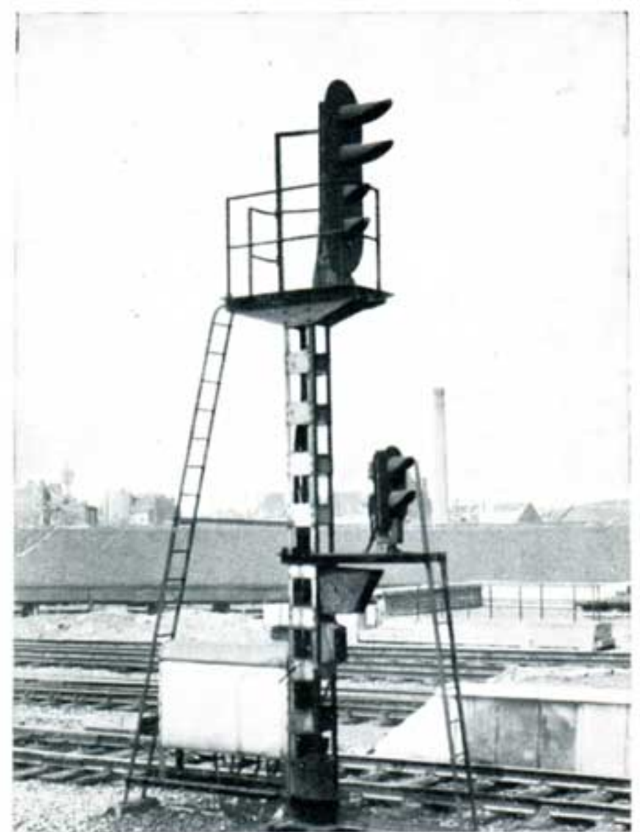
Signaux principaux et de manœuvre dans la gare de Bruxelles-Midi.
