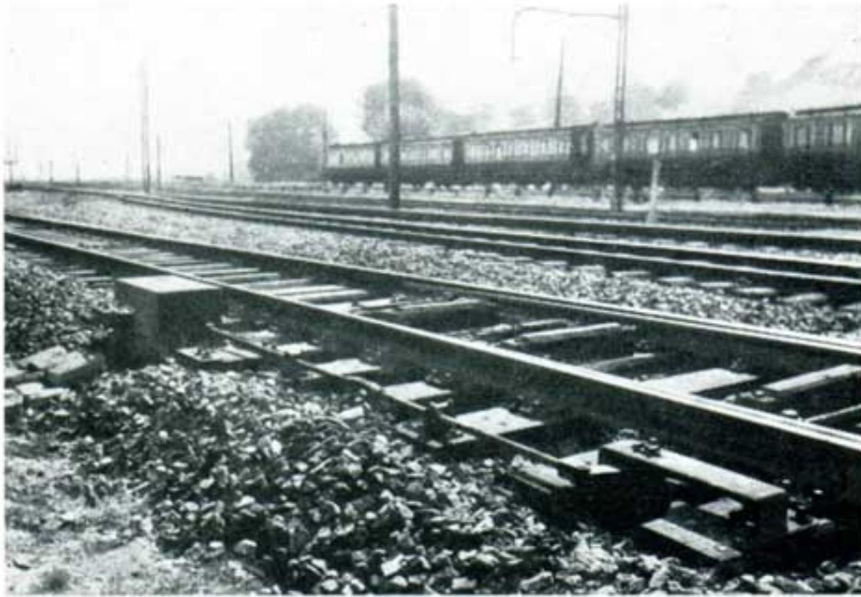
Appareil de manœuvre électrique des aiguillages élastiques (deux crémaillères). Vue d'ensemble de l'attaque de la deuxième crémaillère.
