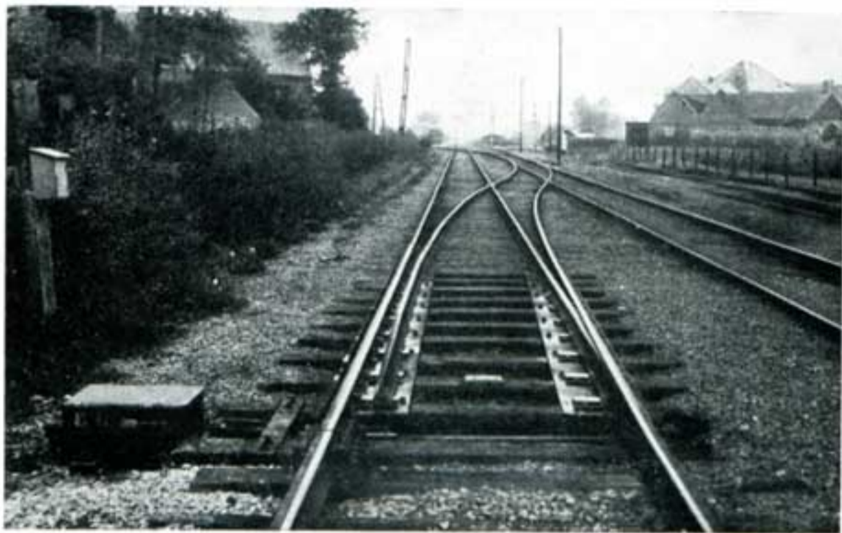
Appareil de manœuvre électrique d'aiguilles munies de crochets, type talonnable. Montage dans la voie.
