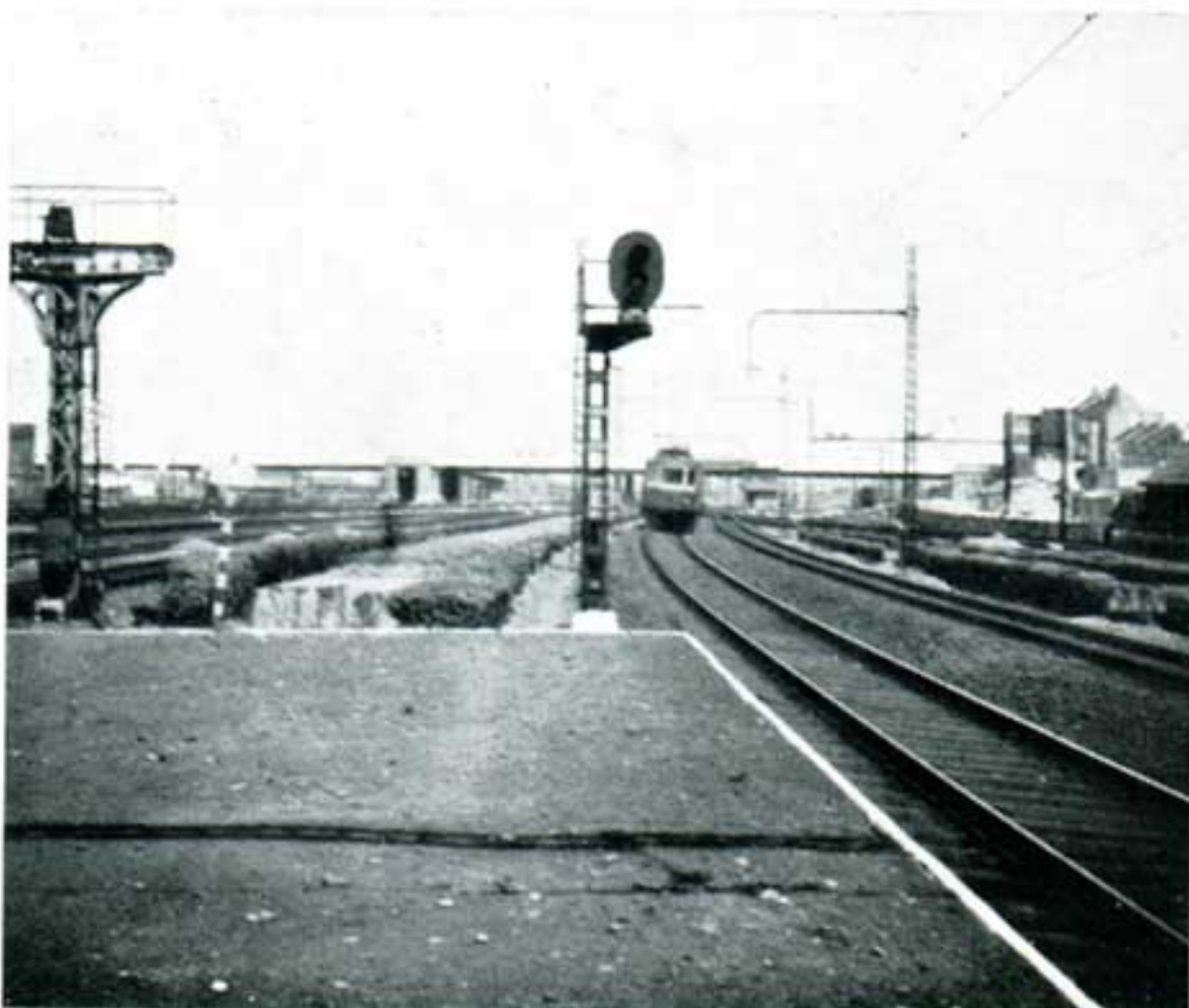
Signal lumineux à la gare de Schaerbeek.
