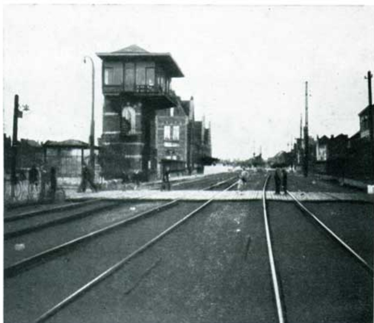
Gare de Hal. Vue extérieure de la cabine électrique.
