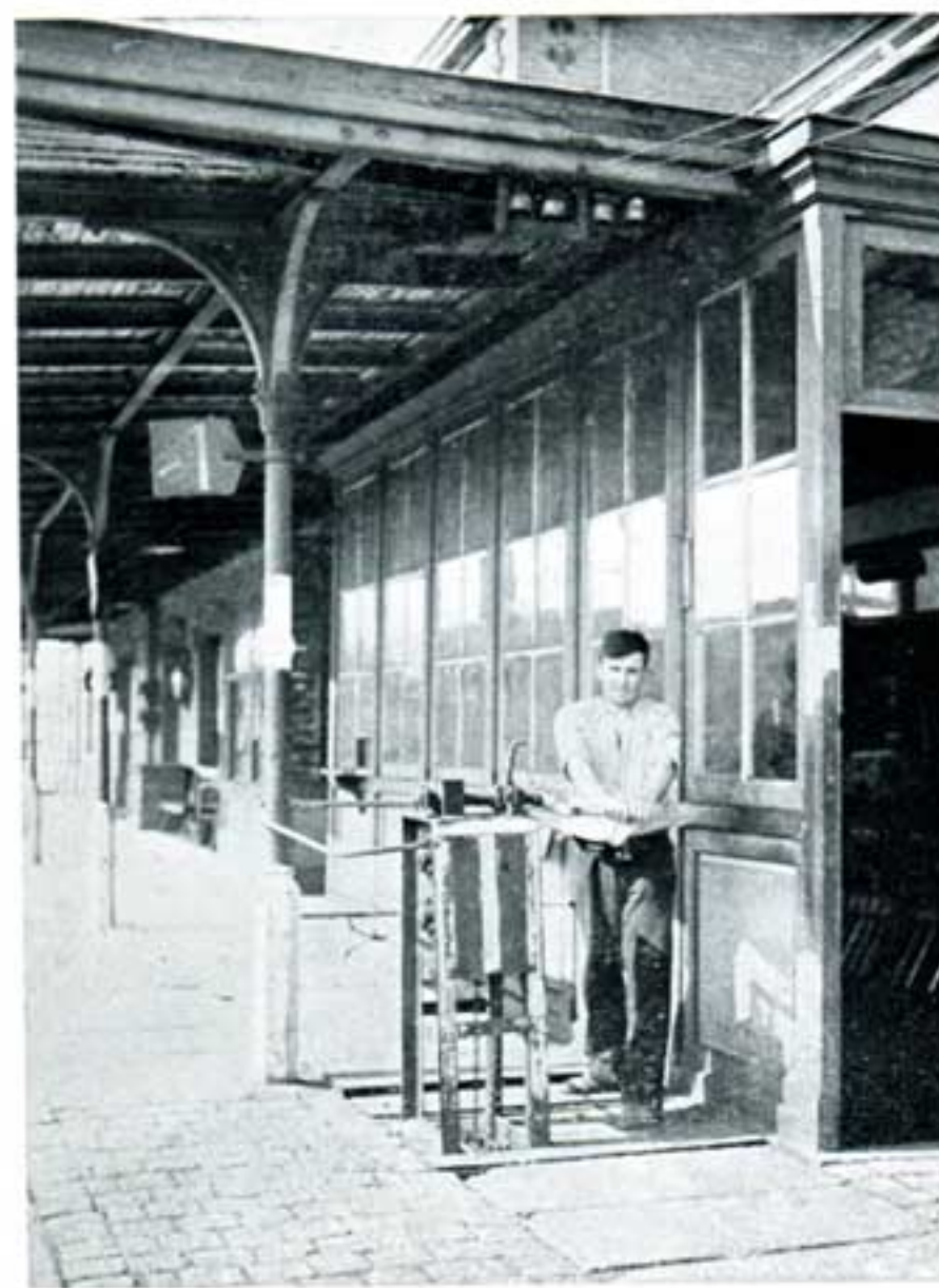
Treuil d'actionnement à distance des barrières basculantes.
