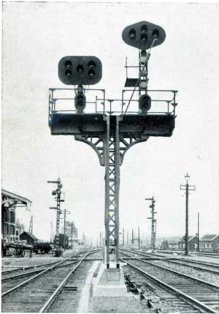
Signaux lumineux dans la gare de Châtelineau.
