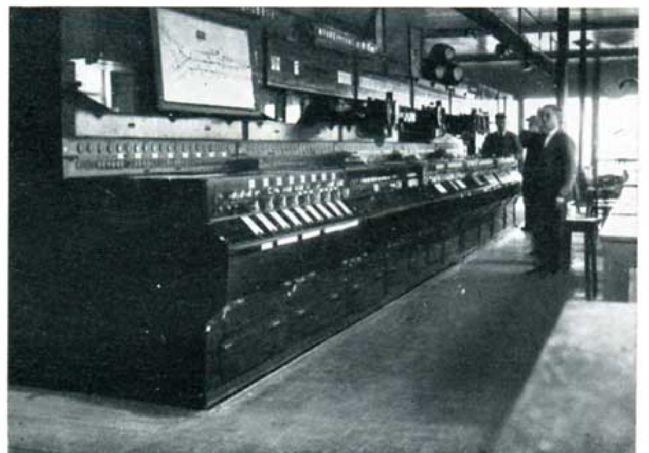
Cabine III de Bruxelles-Nord. Vue intérieure.
