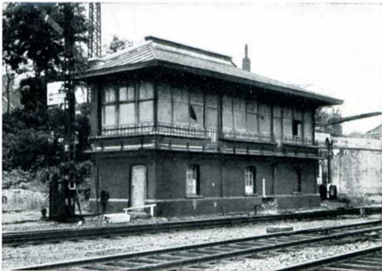
Cabine de Charleroi-Sud. Vue extérieure.
