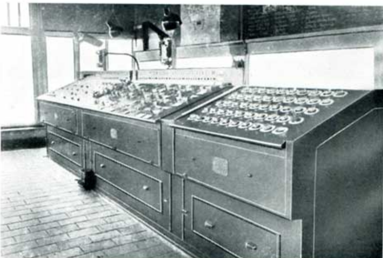
Appareil central électrique pour la manœuvre des aiguillages d'un faisceau de triage à Schaerbeek.
