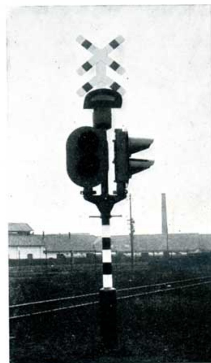
Signal équipé avec deux panneaux à deux feux et cloche d'avertissement pour passage à niveau non gardé.
