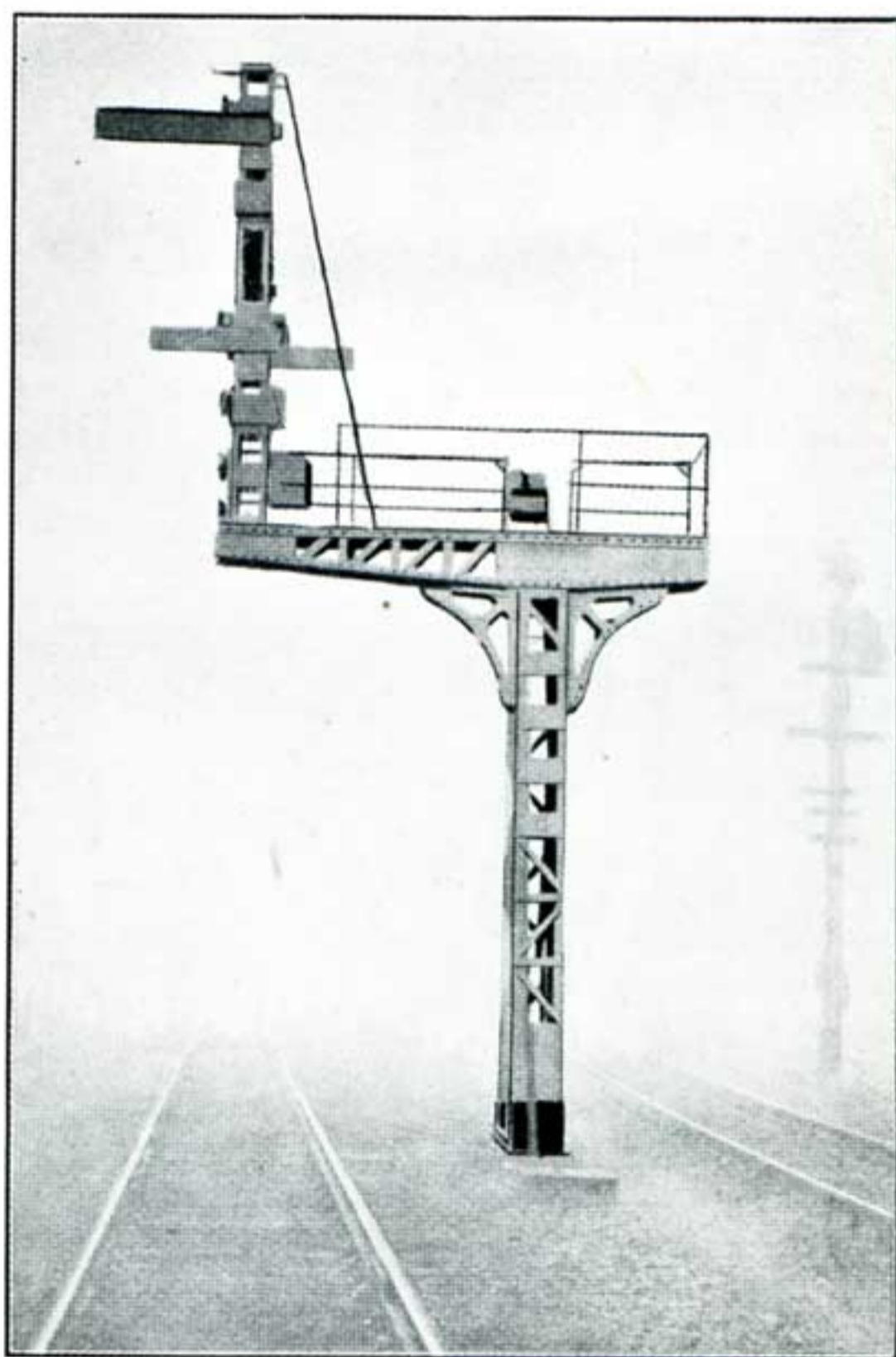
Palettes de sémaphore actionnées par moteur monté sur potence.
