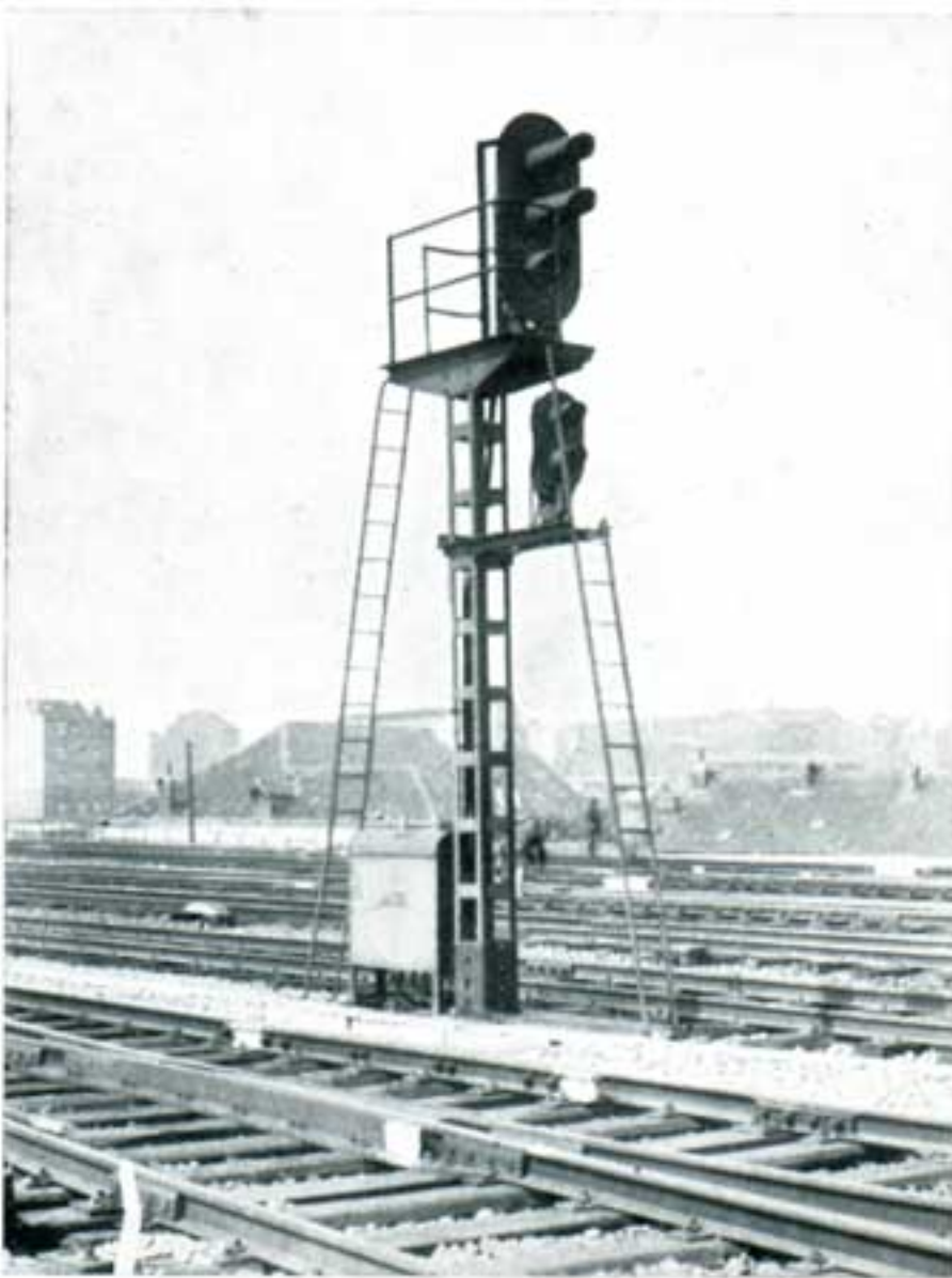
Signaux principaux et de manœuvre dans la gare de Bruxelles-Midi.
