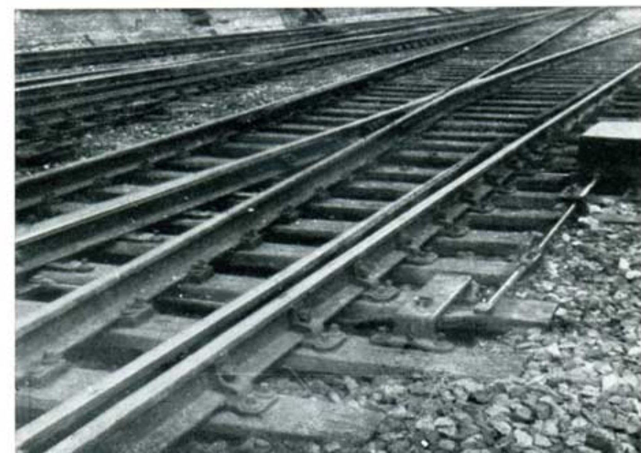
Appareil de manœuvre électrique des aiguillages élastiques à deux crémaillères. Tringlages de la deuxième crémaillère.
