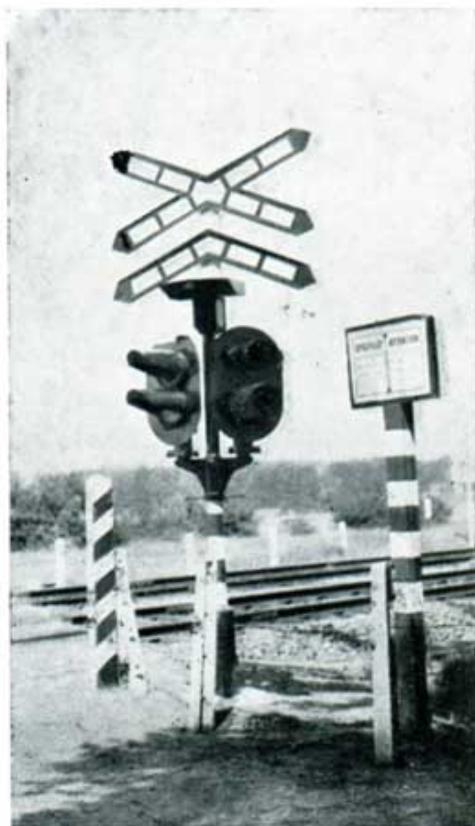
Poteau de signalisation pour deux directions, pour passage à niveau non gardé.
