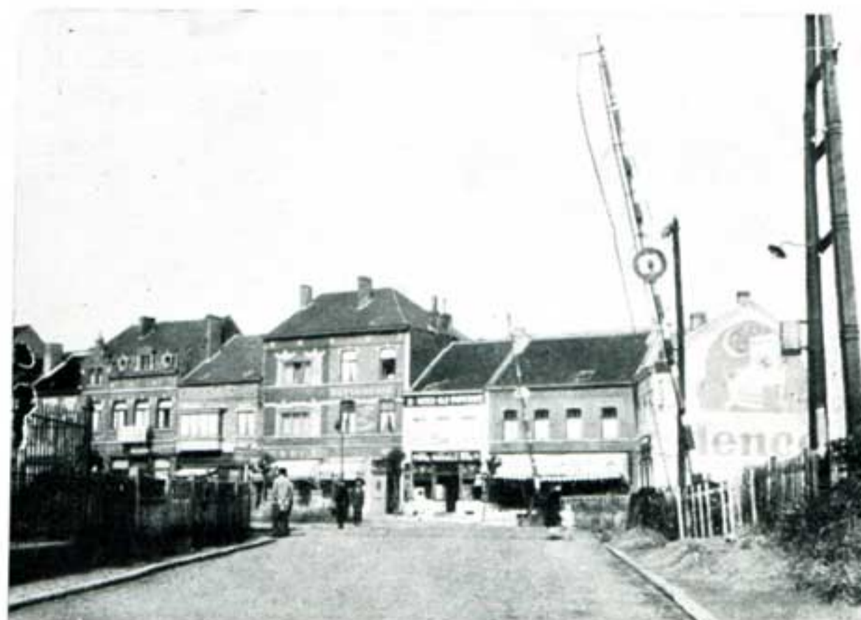
Passage à niveau de la gare de Braine-l'Alleud. Barrières actionnées par treuil. Position levée.
