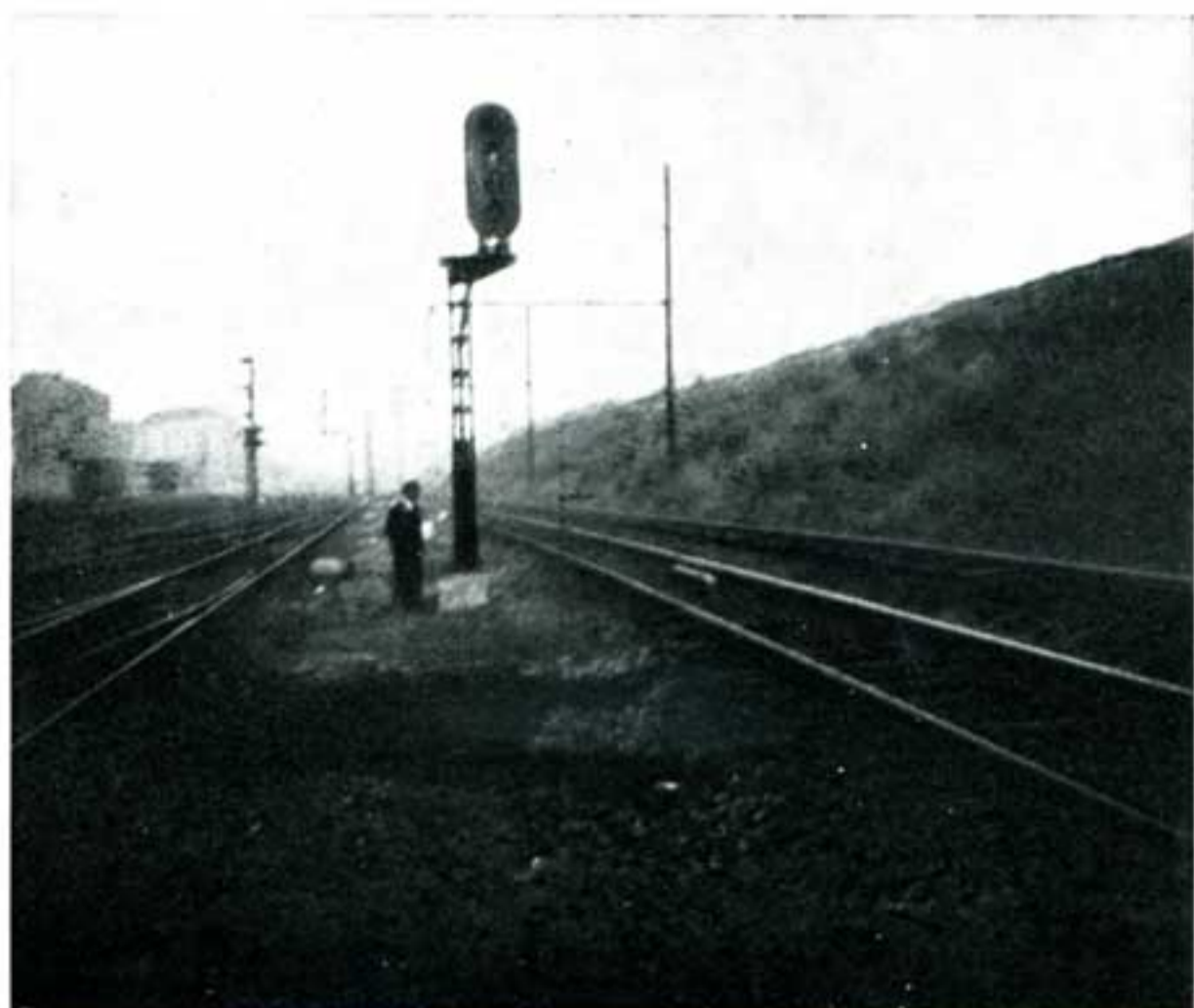
Signal lumineux à la gare de Bruxelles-Nord.
