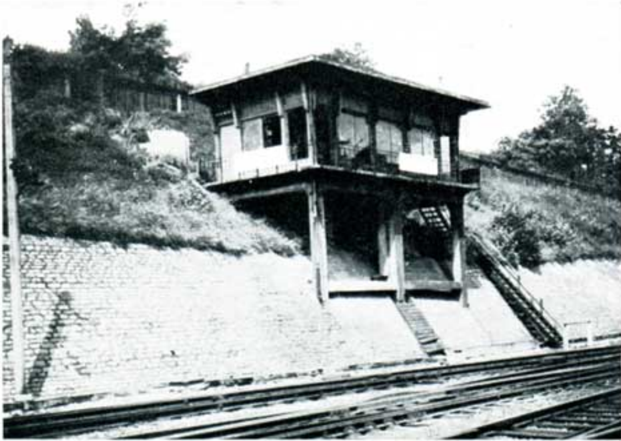
Bifurcation de Pannenhuis. Vue extérieure de la cabine
