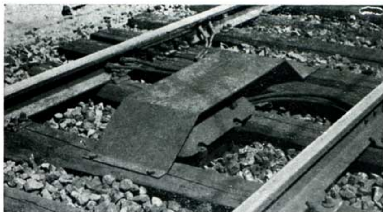
Connexion inductive sur la ligne Bruxelles-Anvers.
