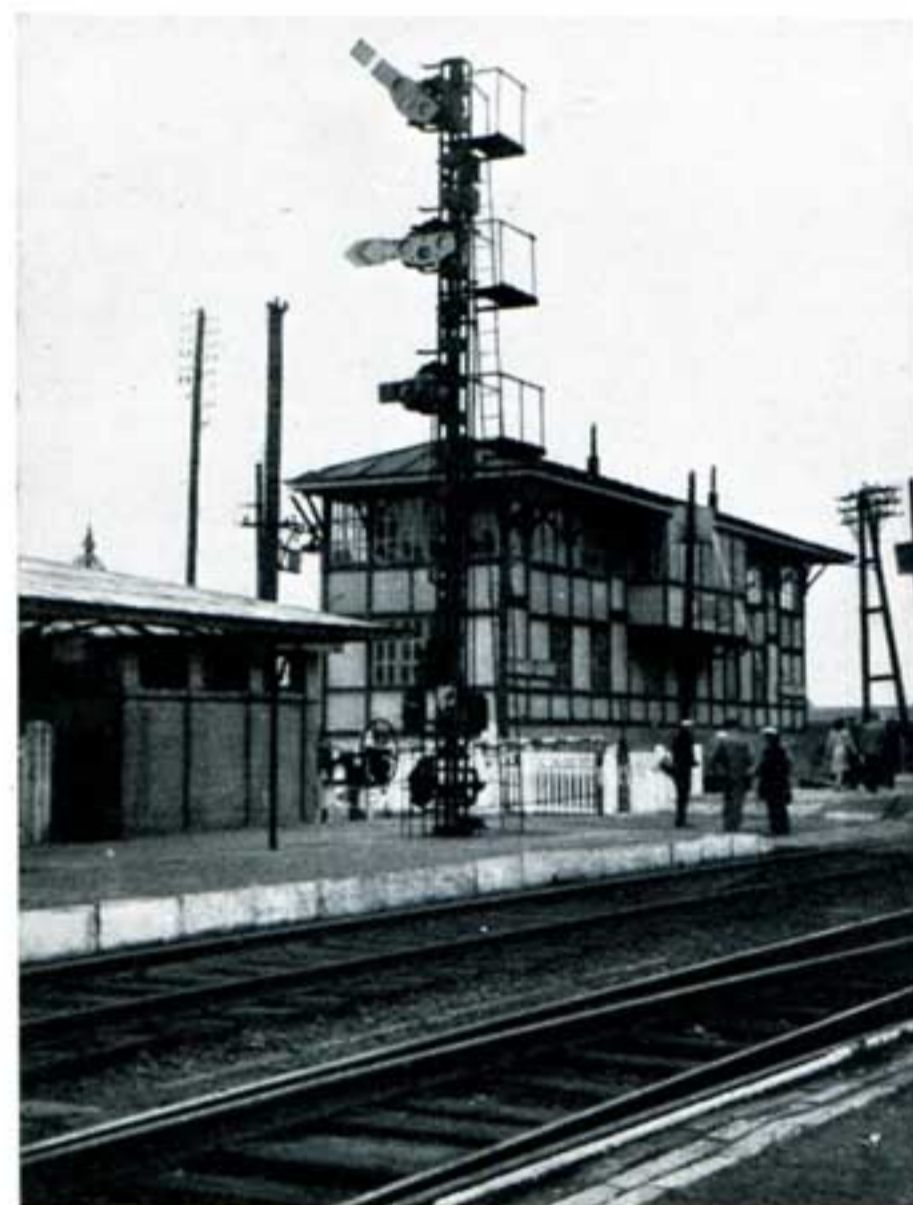
Gare de Forest-Midi. Sémaphore à trois palettes actionnées mécaniquement par l'intermédiaire de poulies à came munies de déclié pour bris de fil.
